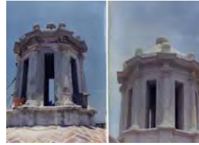
Detalle de la reposición de aplanados
