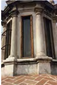
Detalle de ventana elaborada a base de madera, acabado final con cera de abeja
