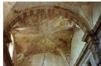
Fabrica en cúpula, a base de una cúpula de concreción y mampostería de tabique de barro.
