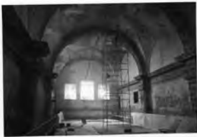
Vista del entrepiso construido por el I.N.A.H. En la época que utilizo las instalaciones como archivo muerto
