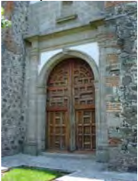
Puerta de madera tipo entablerada, que conectaba, la nave principal con la biblioteca.
