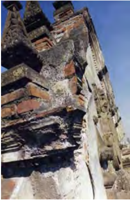
Fabrica en remate; a base de mampostería de piedra y tabique de barro.
