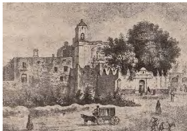
CASA HOSPICIO DE SAN COSME, PRIMER ESTABLECIMIENTO DE ESTE TIPO FUNDADO EN MÉXICO POR LOS FRANCISCANOS OBSERVANTES 46 .
