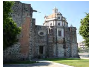
Corredores exteriores, a base de concreto
