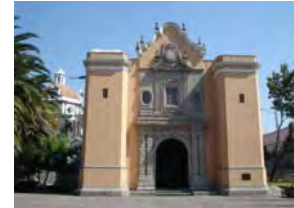
Piso exterior a base de laja de piedra rosa
