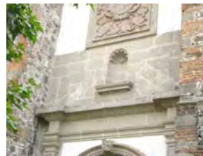
Detalle de ornamentación exterior, a base de cantera rosa.
