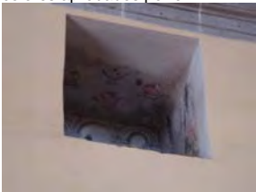
Vestigios de la pintura a la cal, original dentro de la nave principal (pintura al temple)
