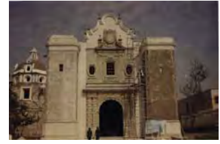
Vista de la aplicación del aplanado exterior
