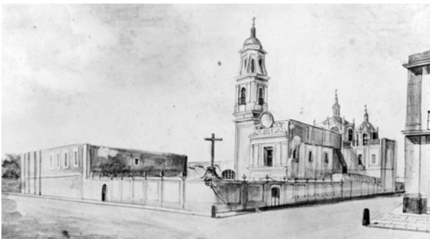
IMAGEN DEL CONVENTO DE SAN DIEGO DE MÉXICO, UBICADO A UN COSTADO DE LA ALAMEDA (EX PINACOTECA VIRREINAL Y ACTUALMENTE, MUSEO DE ARTE ALAMEDA) 49
