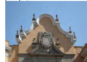
Ornamentación del remate de la portada principal, a base de cantera rosa.
