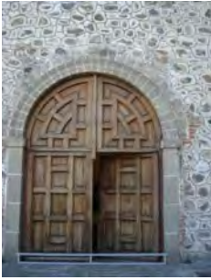
Puerta (purcincula), tipo entablerada. Acabado final, a base de cera de abeja
