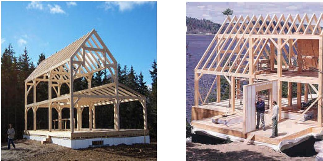
Figura 125. Estructura con elementos de madera maciza.
