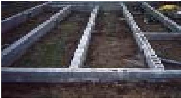
Figura 145. Cimentación superficial de concreto armado.
