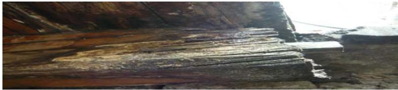
Figura 25. Degradación de la madera por el efecto de los hongos que producen la pudrición.
