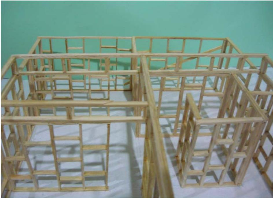
Figura 112. Entramado de madera para los diferentes compartimentos.
