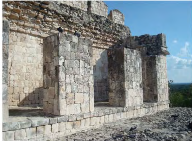
CUERPO SUPERIOR EDIFICIO DE LOS CINCO NIVELES
