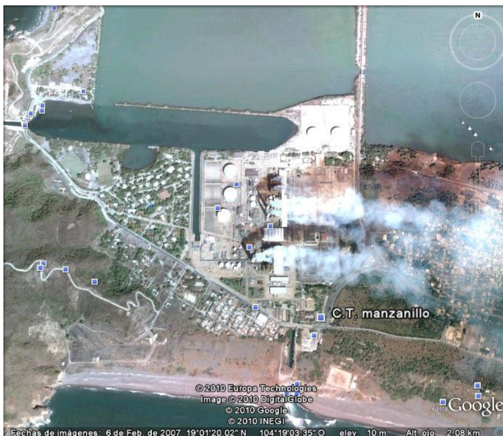
Figura II.2. Vista satelital de la CTM, INEGI 2010- Google 2010
