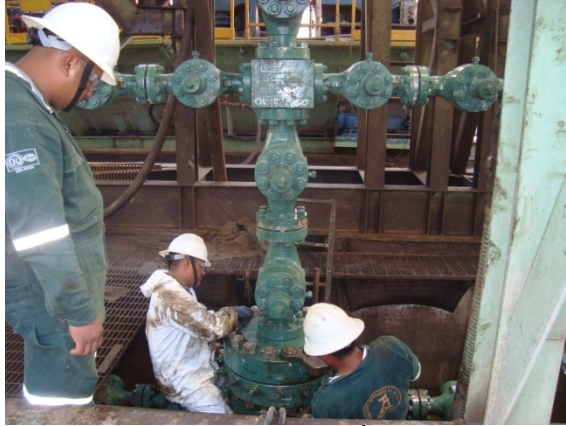
FIGURA 3-12. Instalando Medio Árbol de Válvulas.
