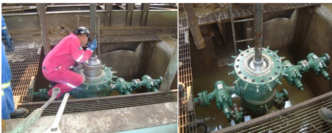
FIGURA 3-10. Izquierda: Tensiona y Coloca Empaque Sello al Colgador. Derecha: Regresa Colgador a Nido en Cabezal.
