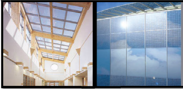
Figura 3.11 Tipos de cristales en la tecnología BIPV. Pueden ser transparentes (izquierda) o semitransparentes (derecha) adecuándose al diseño del edificio. Fuente: Sitio web BIPV Building Integrated Photovoltaics
