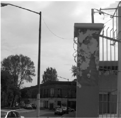
Fig. 43. Alumbrado público es uno de los servicios básicos en la ciudad junto con el servicio eléctrico, agua, drenaje, y el manejo de desechos sólidos.
