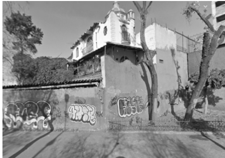
Fig. 2. ejemplo de remanente sobre Reforma entre calle Jaime Nuno y González Bocanegra se aprecia con claridad la falta de continuidad de la fachada a la izquierda una antigua casa con un patio mutilado y delimitado por un muro ciego lleno de graffiti. Casos como este se repiten con frecuencia en la zona de estudio
