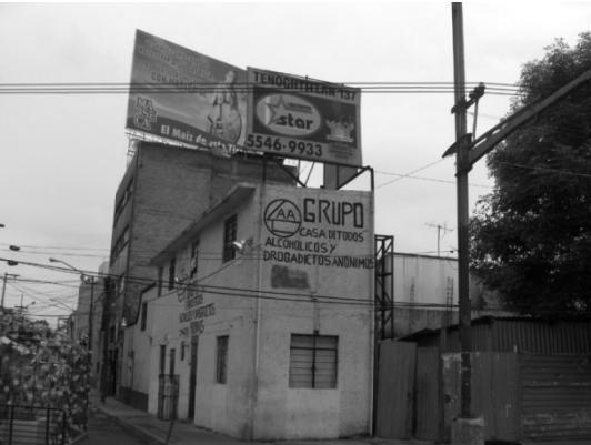
Fig. 37. Edificación en mal estado de conservación sobre Paseo de la Reforma a un costado de un predio invadido. Actual sede de Grupo de Alcohólicos Anónimos.
