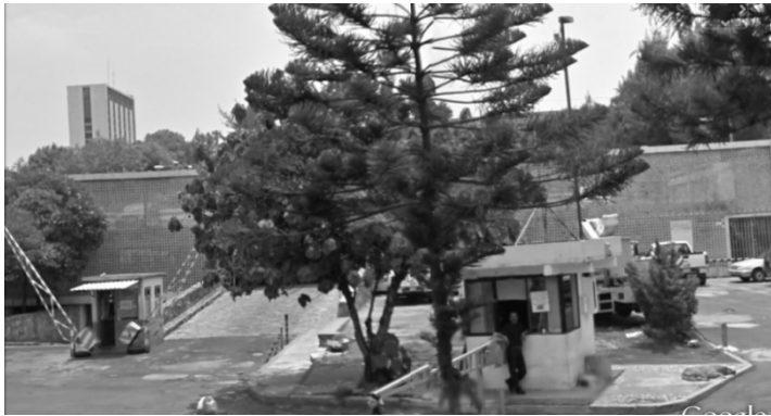
Fig. 92. Casi a la mitad del recorrido se encuentran edificios de menor altura de equipamiento para la unidad habitacional. Sin embargo esto no rompe el patrón de toda la manzana, cuenta con un estacionamiento al frente, rodeado por vegetación y al fondo del croquis de puede mirar la antigua torre de la SRE actualmente en rehabilitación.
