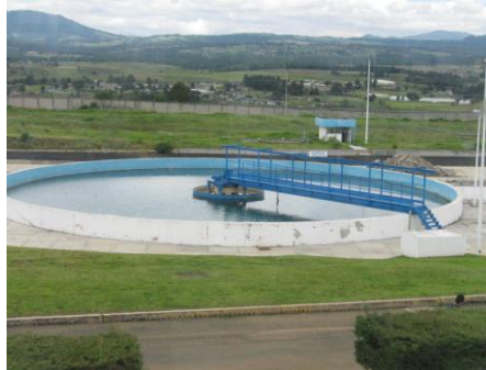
Figura 1.8 Espesador de lodos en la planta Los Berros
