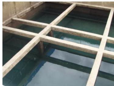
Figura 1.7 Filtración final en la planta Los Berros
