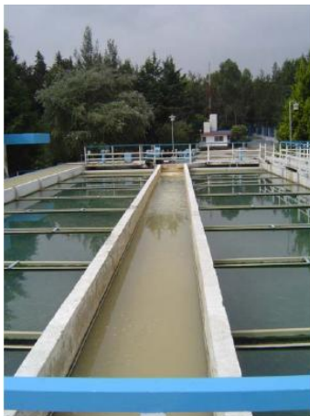
a) Tanques de sedimentación
