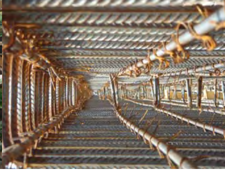
Cimbras y armado de varilla corrugada
