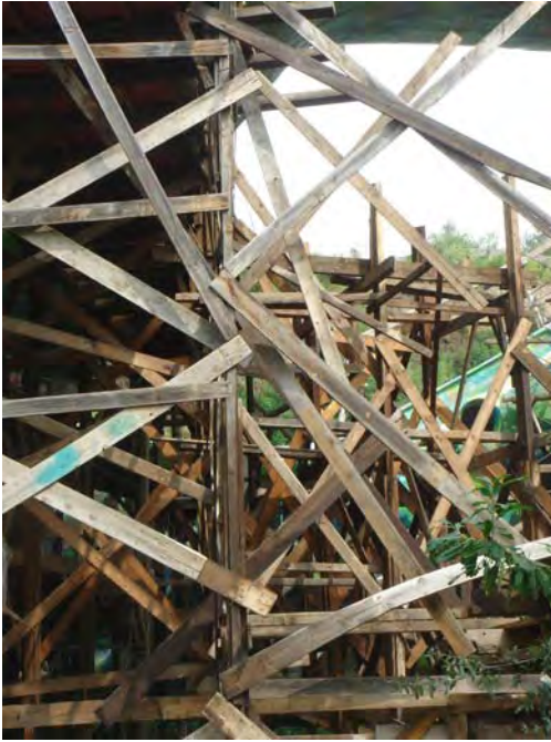
Cimbras y armado de varilla corrugada
