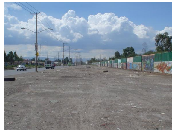
Imagen 26. Se observa que no existe pavimentación.
