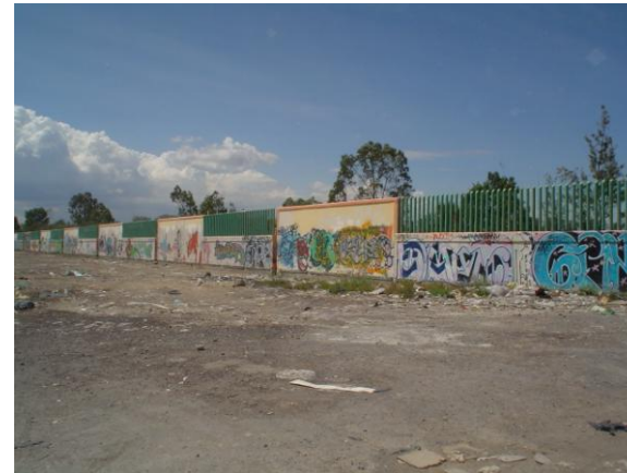
Imagen 25. Se observa la existencia de graffiti en los muros.
