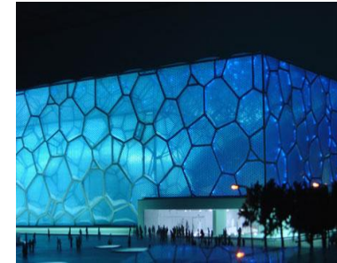
Fachada principal del Cubo de Agua (China).
