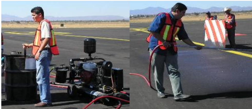
Figura. III.11.2.8.- Preparación y aplicación de sello a base de alquitrán de hulla
