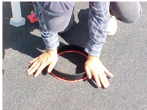
Figura. III.18.3. Colocación de aro sobre carpeta asfáltica
