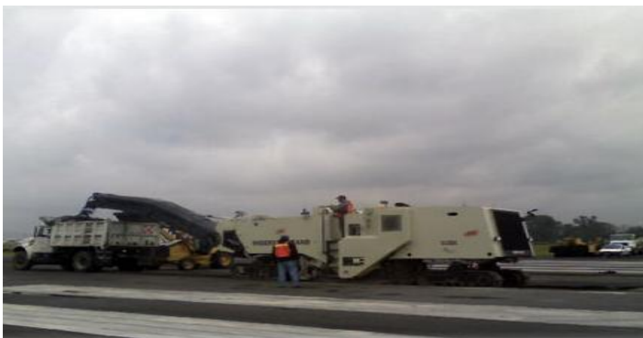
Figura. III.11.1.2.- Cortadora tipo Rotomill.
