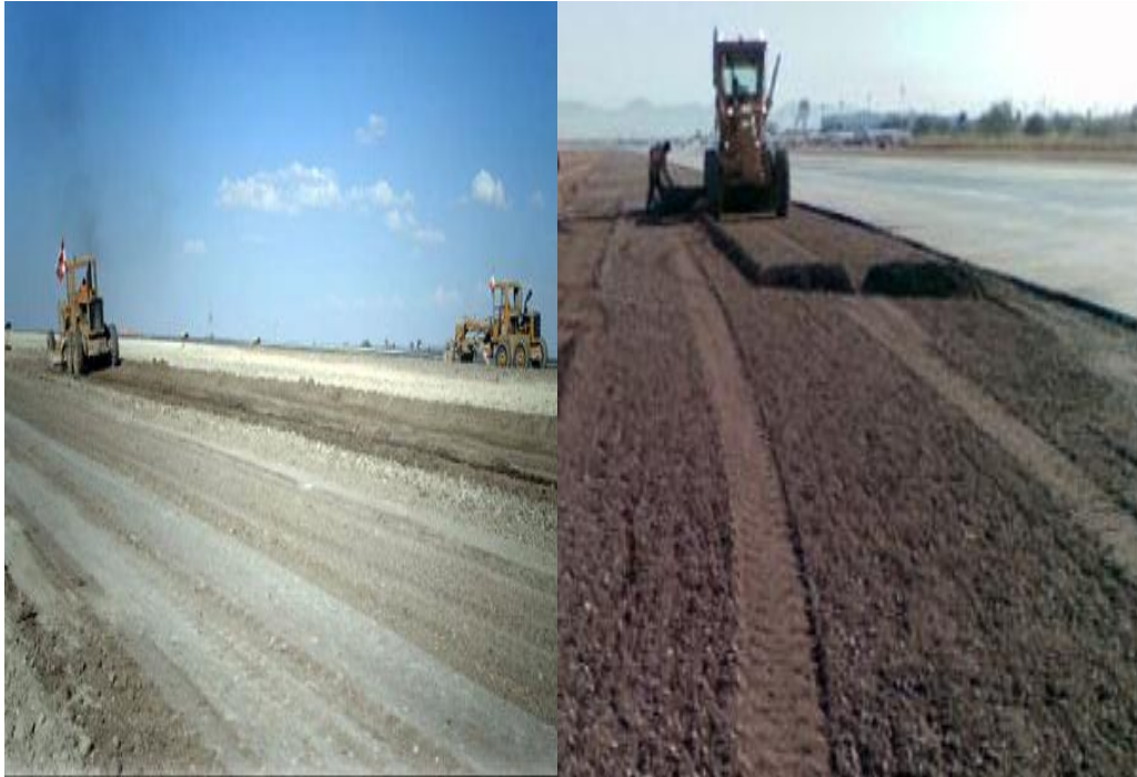
Figura. III.13.3.- Conformación de franjas de seguridad de pista 17-35
