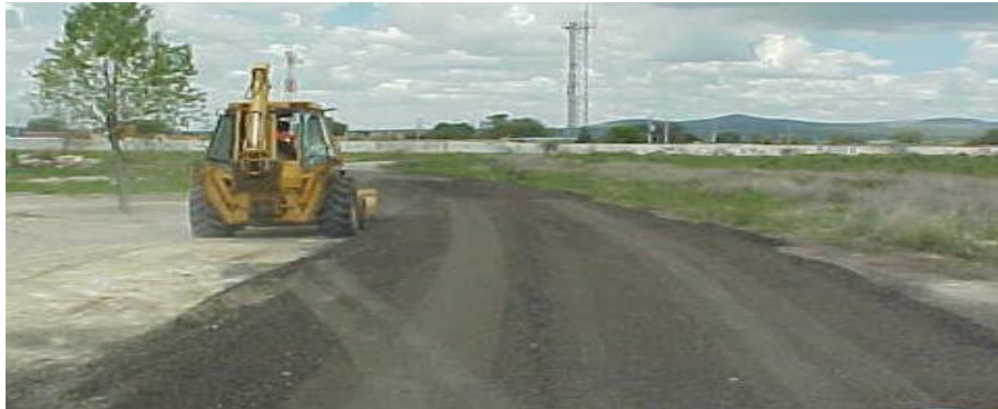
Figura. III.11.1.2. Material producto de corte.
