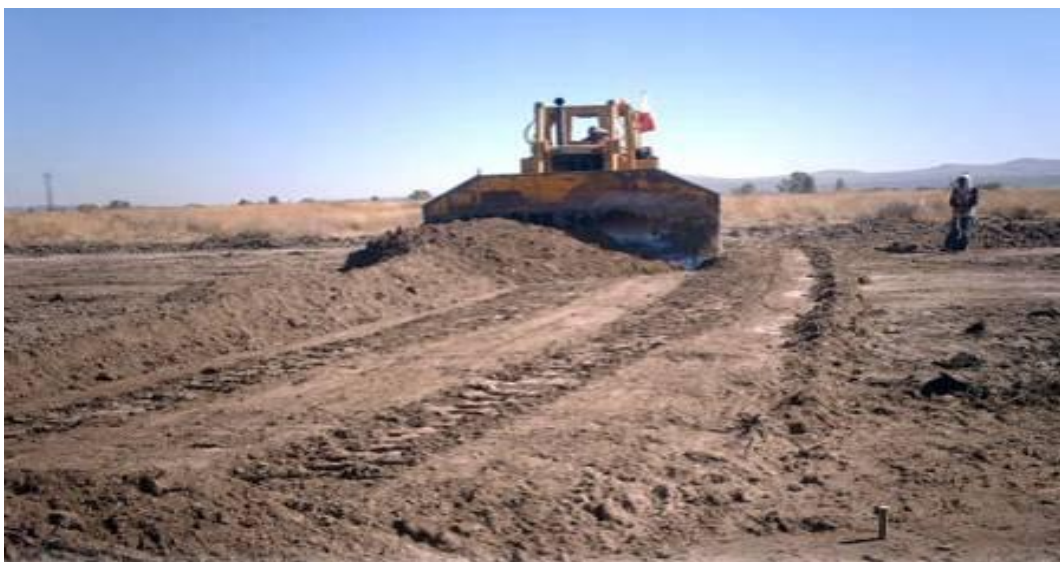
Figura. III.12.2.- Despalme de material en franjas de seguridad pista 17-35
