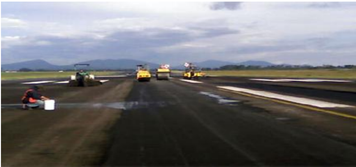
Figura. III.11.2.7.- Compactación de carpeta asfáltica con equipos autopropulsados sobre margen de pista
