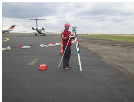
Figura II.2.3 Brigada de topografía realizando nivelación diferencial.
