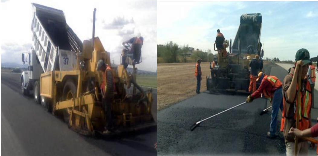
Figura. III.11.2.5.- Suministro y colocación de mezcla asfáltica sobre margen de pista.
