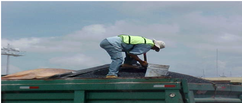
Figura. III.17.1.1. - Toma de muestra de material asfáltico.
