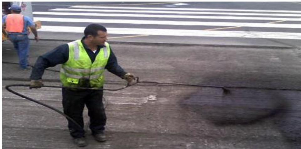
Figura. III.8.6.1.5. Riego de liga en margen de pista.
