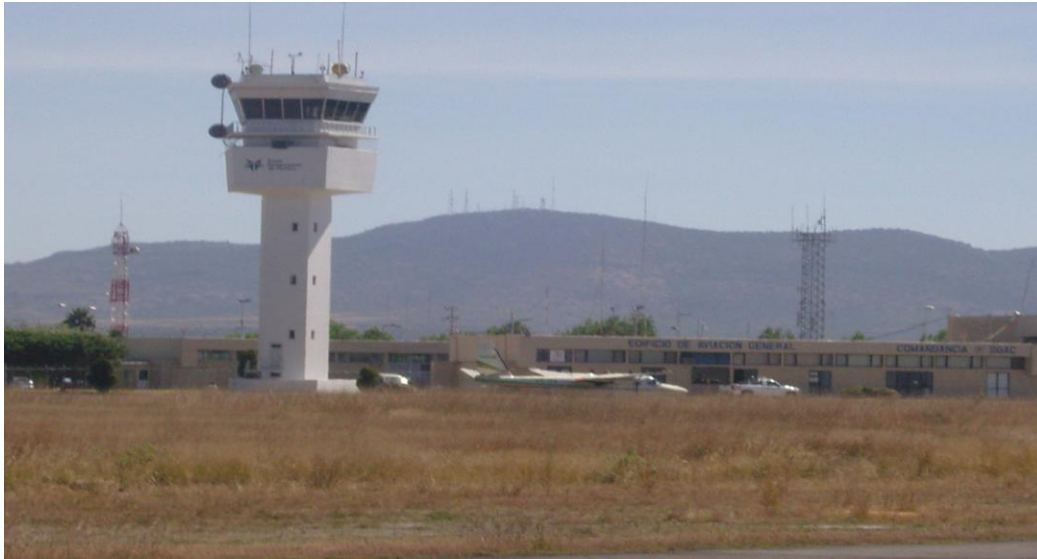
Figura I.2.2 instalaciones de apoyo
