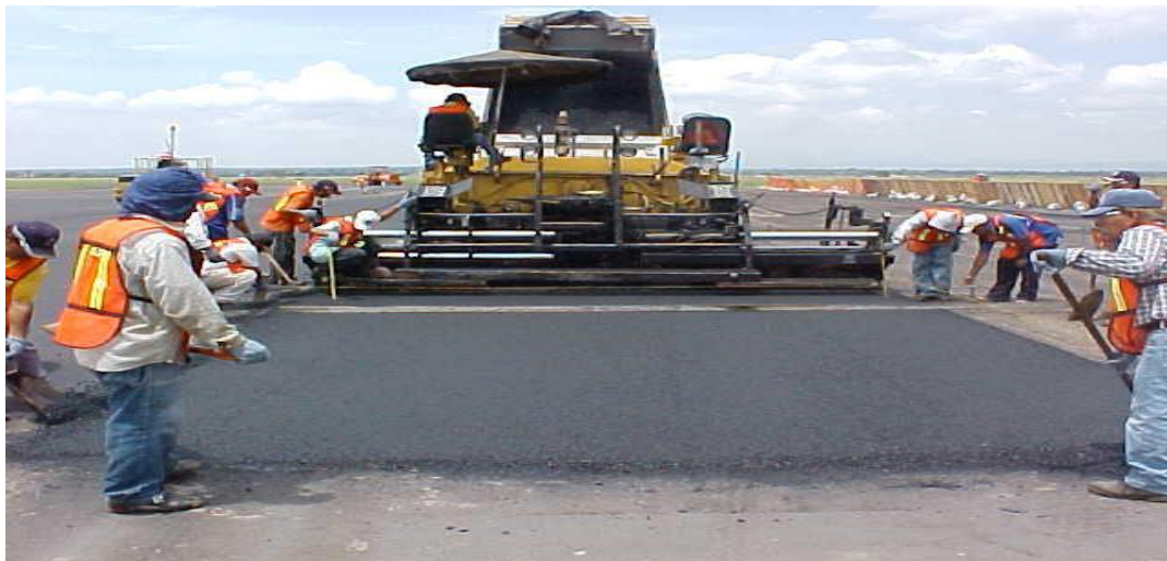
Figura. III.11.2.6.- Verificación de uniformidad de carpeta con regla de aluminio.
