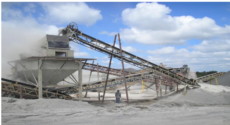
Figura. III.10.1.1.2 Alimentando las tolvas con banda transportadoras
