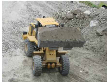
Figura II.4.4. Banco de material puente el salto.
