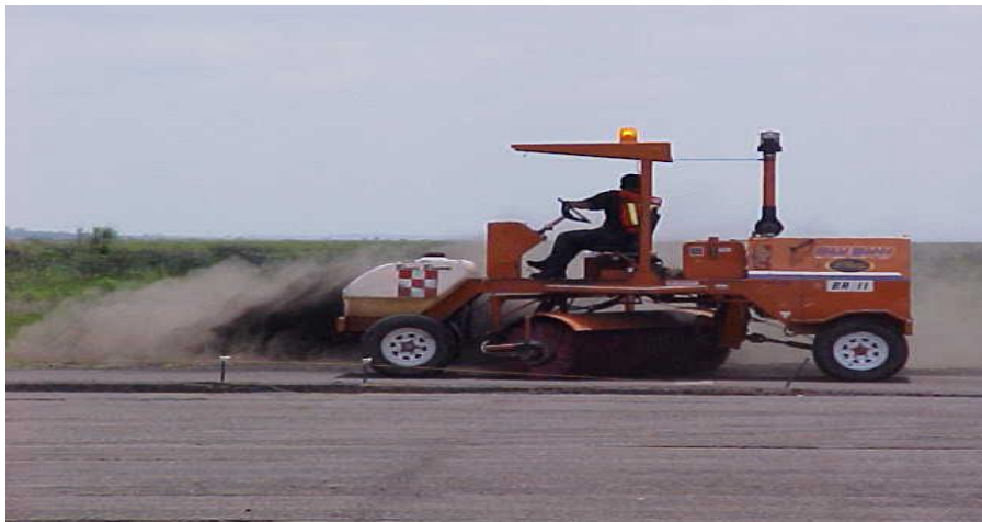
Figura. III.11.1.3.- Barrido de material producto del corte.
