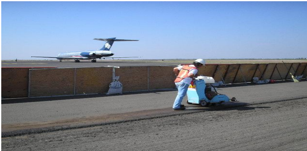
Figura. III.11.1. Perfilado de Carpeta.
