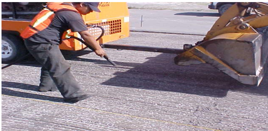
Figura. III.11.1.3.- Barrido de material producto del corte.
