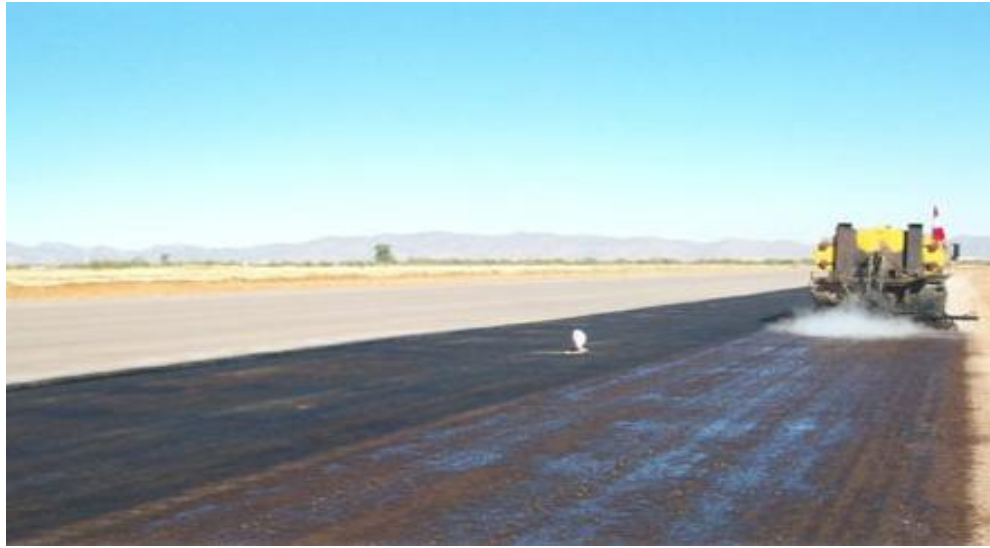
Figura. III.11.2.1.- Riego con petrolizadora en márgenes de pista.
