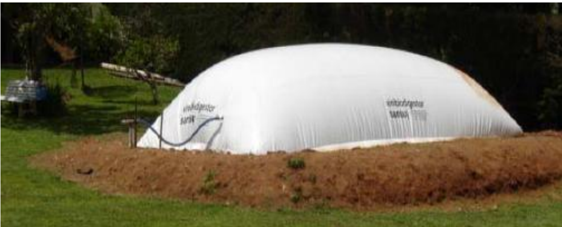
Figura 2.17 Digestor para tratamiento de residuos ganaderos
