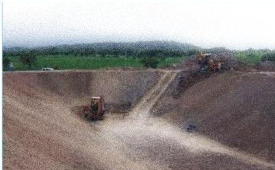
Figura 4.2 Fase de excavación
