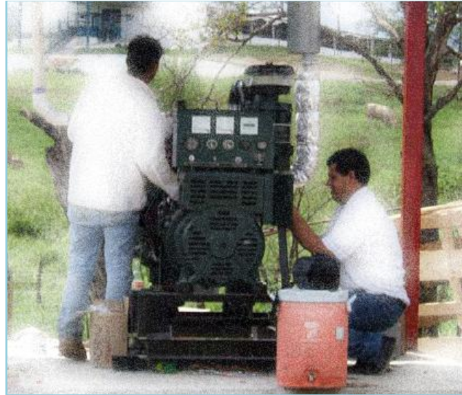
Figura 4.11 Instalación del equipo motogenerador
