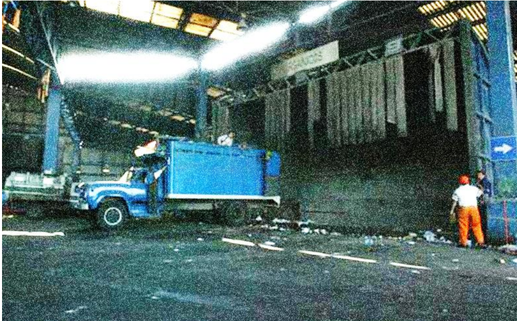
Figura 1.11 Instalaciones de la estación de transferencia Chabacano-La Viga
