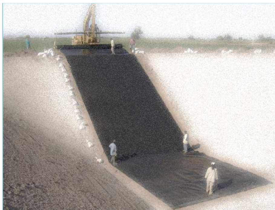
Figura 4.3 Colocación de la geomembrana
