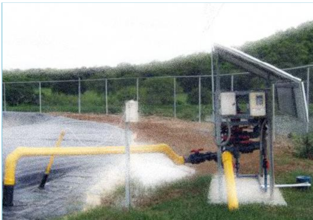
Figura 4.10 Equipo para medir producción de biogás
