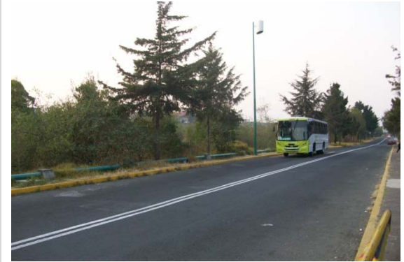
Vista del lado derecho del terreno
