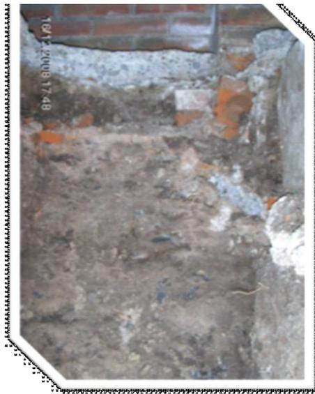
Losa de concreto de aproximadamente 10cm de espesor, subyaciendo una capa de relleno constituida con arcilla y pedacería de ladrillo rojo.
