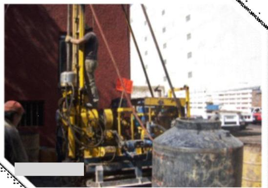
Posicionamiento y nivelación del equipo, para dar inicio con la exploración profunda.
