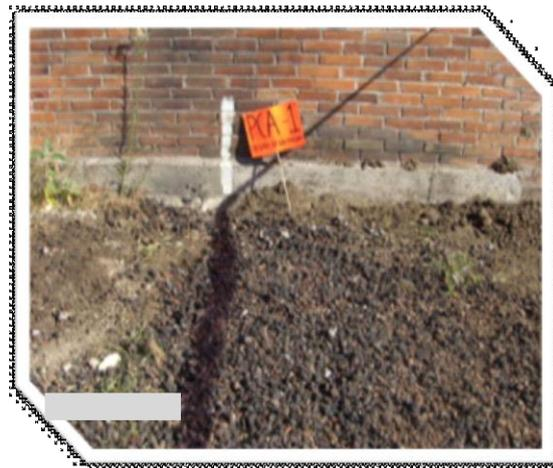
Pozo a cielo abierto No. 1, el cual al terminar de realizar la exploración y el muestreo se relleno con el material producto de su excavación.
