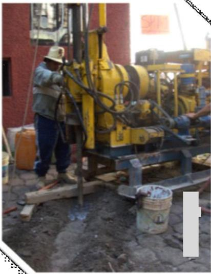
Inicio del sondeo, realizando el primer avance en el suelo con la broca tricónica.
