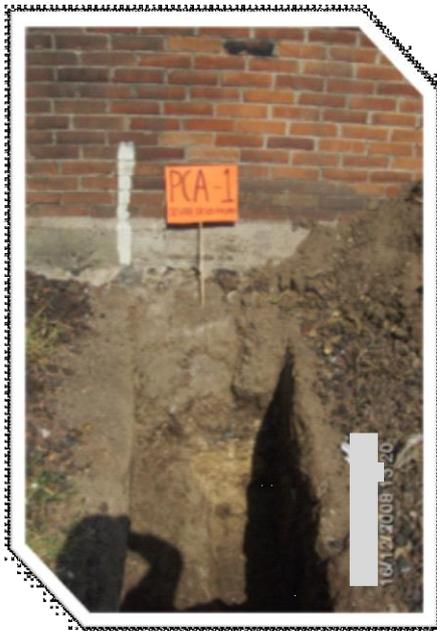
Imagen en la cual se aprecia la cimentación del muro que delimita el predio, la cual consta de una zapata corrida.
