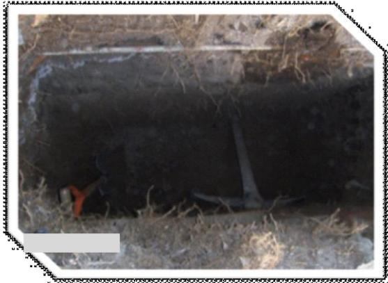
Excavación del pozo terminada, en donde se realiza el muestreo de cada estrato de suelo que hay en el lugar de la excavación.
