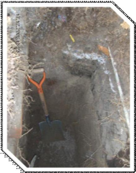
Imagen en la cual se aprecian los diferentes espesores que tiene cada estrato de suelo en este pozo.
