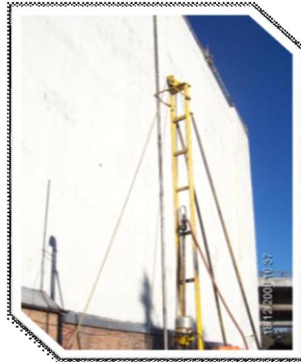
Imagen de las barras acopladas, conforme se avanza en la profundidad del sondeo.
