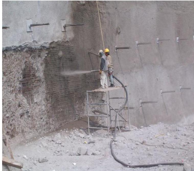
**APLICACIÓN DEL CONCRETO LANZADO.**
