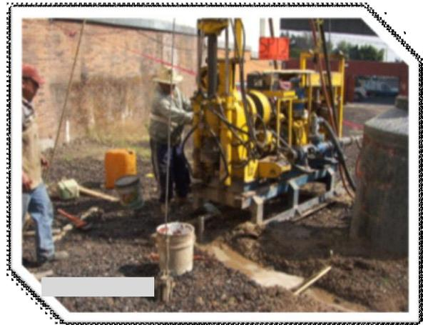
Inicio del barrenado para el SPT-2, en donde se aprecia la salida del lodo bentonítico utilizado para la estabilización de las paredes de la perforación y el lavado de la misma.
