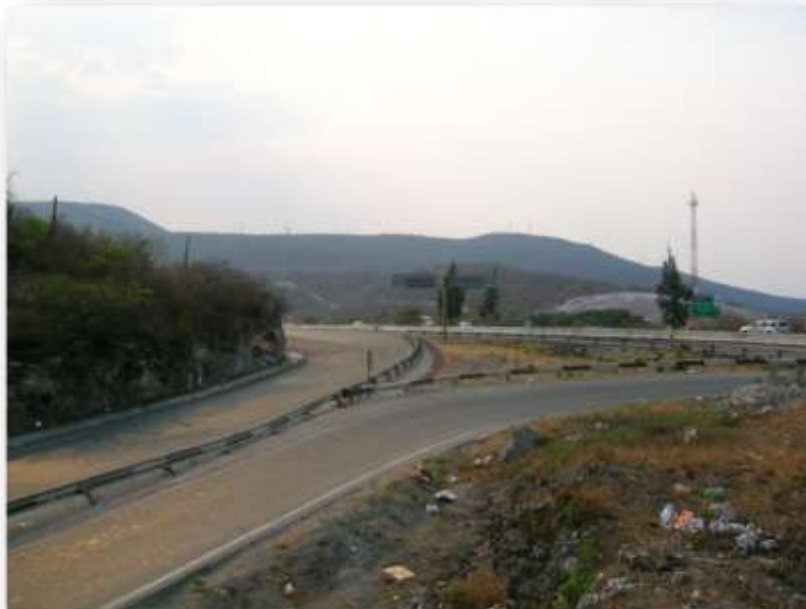
Vista del entronque y una cementera ubicada en el lugar.
