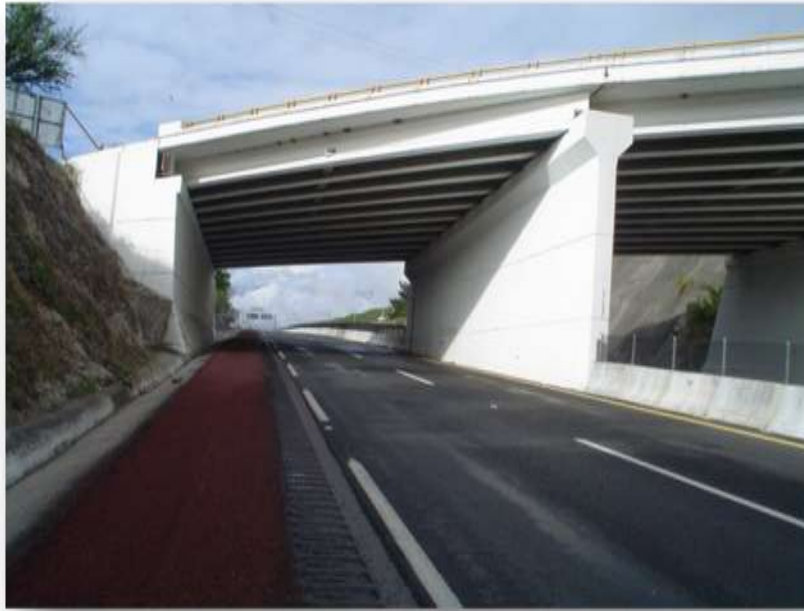
Autopista Del Sol, Dirección Ciudad de México
