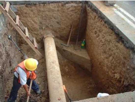
Foto No. 5 Muestra la excavación con medios manuales, observe los cuidados a la tubería de agua potable a medir.
