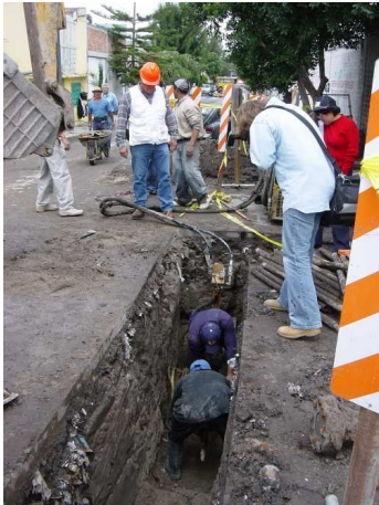
e) Instalación de tubería de polietileno mediante el método de reventamiento.
