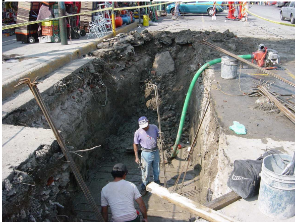
Figura 68.0.- Colado de losa de fondo en caja de medición de flujo.
