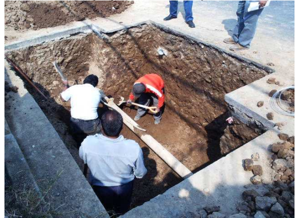
Figura 67.0.- Excavación para Estaciones de Medición de flujo y Control de presión
