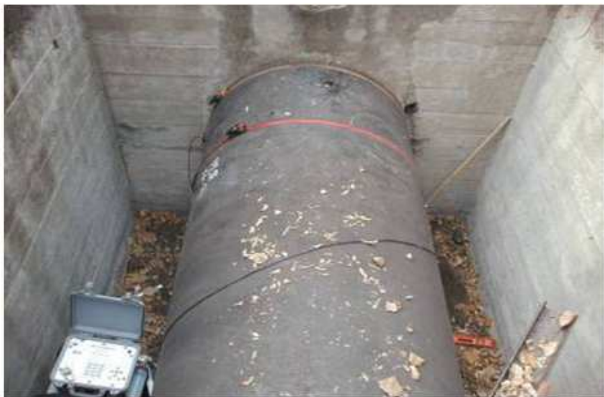
Figura 47.0.- Medidor ultrasónico de tecnología tiempo en tránsito con sensores secos.
