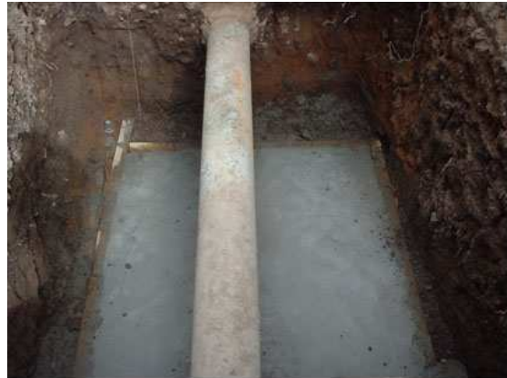
Foto No. 6 Muestra la plantilla de concreto pobre, sobre la cual se realiza el desplante de la losa de piso de las cajas de medición de gasto y control de presiones.
