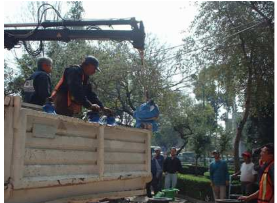
Foto No. 12 Muestra la Utilización de una grúa, para bajar todo el equipo y piezas especiales que serán instalados en la caja de medición.
