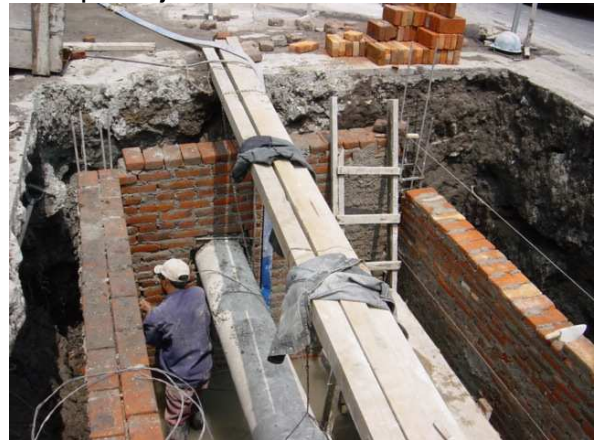
Figura 69.0.- Construcción de muros a base de tabique rojo recocido
