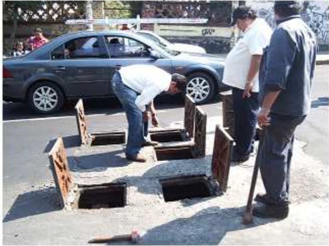
Figura 94.0.- Cierre de válvulas de seccionamiento en la periferia del sector.
