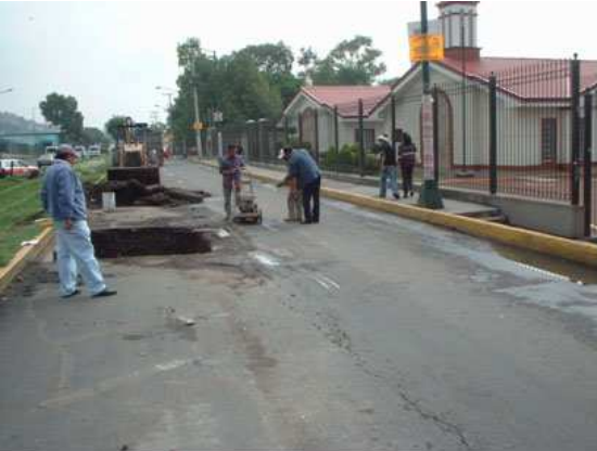
Foto No. 3 Muestra el corte de la carpeta asfáltica, para la construcción de las cajas de medición de gasto y control de presiones.
