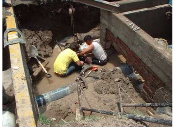
Foto No. 16 Muestra una de las condiciones de trabajo que se pueden presentar durante la instalación de las piezas especiales de las cajas de medición de gasto y control de presiones.
