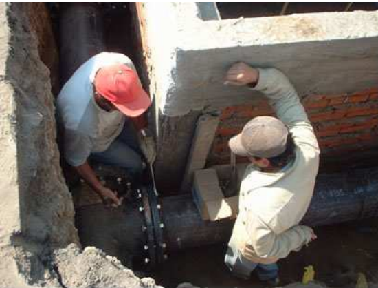
Foto No. 17 Muestra otra de las condiciones que se pueden presentar durante la instalación de las piezas especiales.
