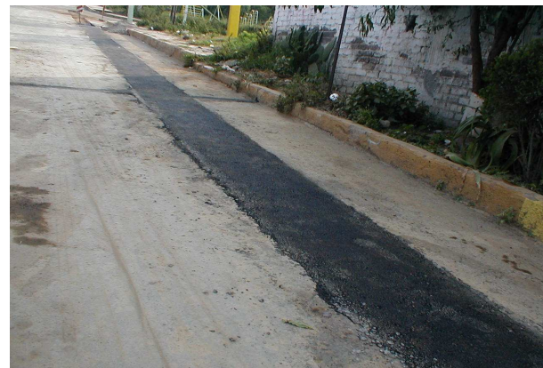
j) Construcción de carpeta de concreto asfáltico
