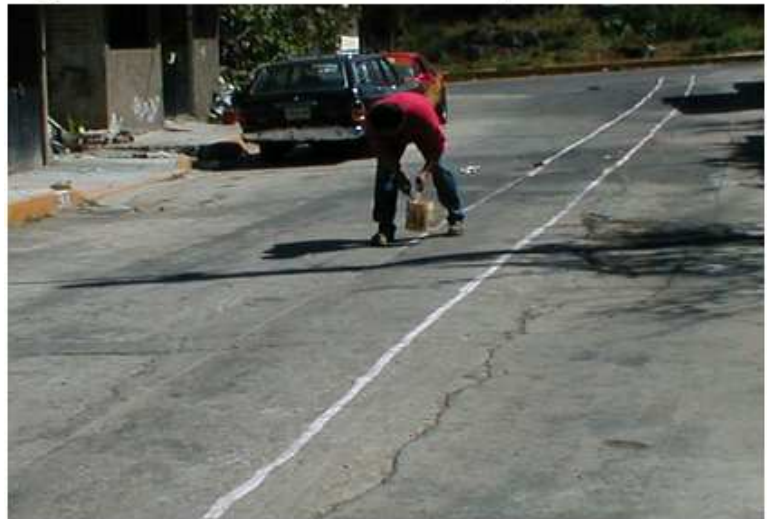
Figura 78.0.- Trazo inicial de tubería para interconexión.
