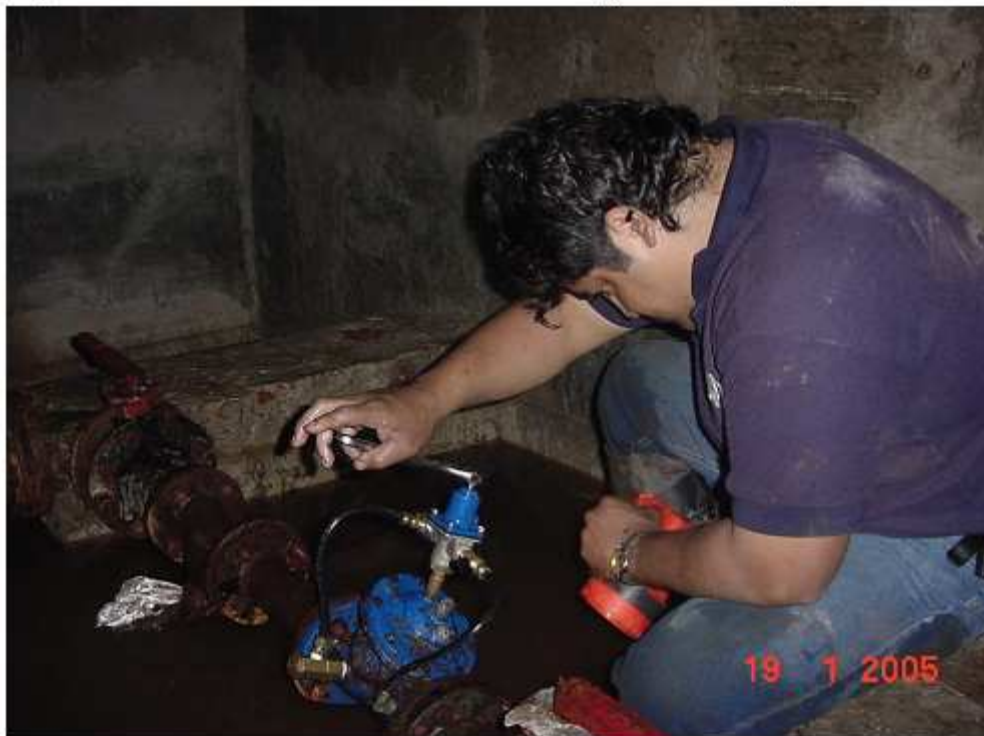
Figura 97.0.- Mantenimiento a válvula reguladora de presión
