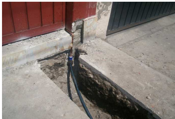
i) Se observa una de las tomas reconectadas.
