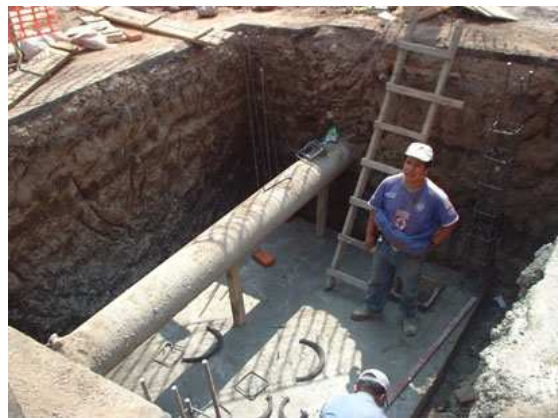
Foto No. 8 Muestra la losa de piso y el armado del acero de refuerzo de los castillos de las cajas de medición.
