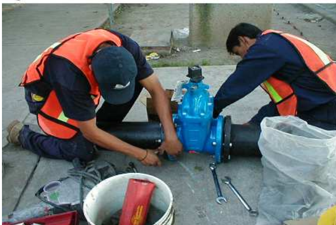
Figura 79.0.- Instalación de una válvula de seccionamiento
