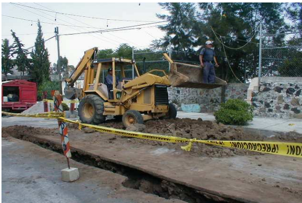
g) Excavación de zanja una vez instalada la tubería
