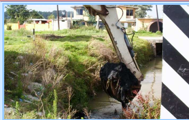
Foto No. 2 Muestra el Desazolve de cunetas y ríos paralelos al acueducto de gravedad
