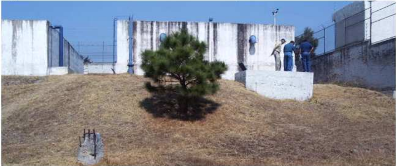
Figura 62.0.- Revisión de funcionamiento de un tanque de almacenamiento y regulación
