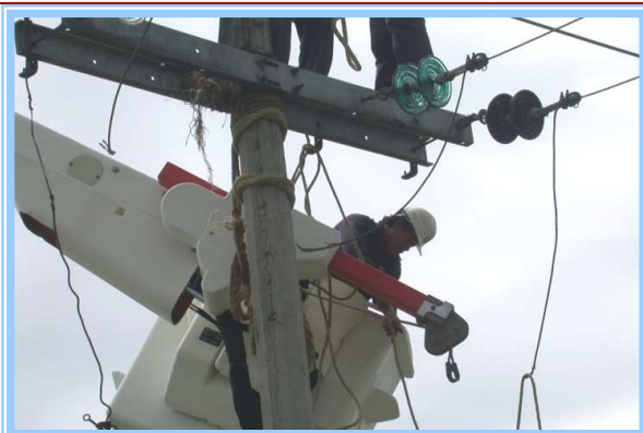
Foto No. 1 Muestra el Mantenimiento a líneas eléctricas de alta tensión
