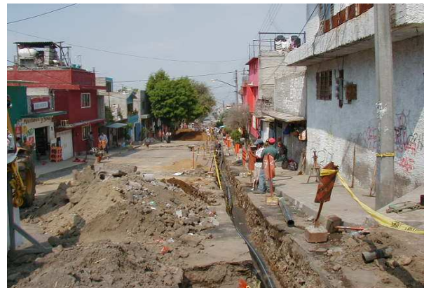
h) Instalación de tubería de polietileno de alta densidad
