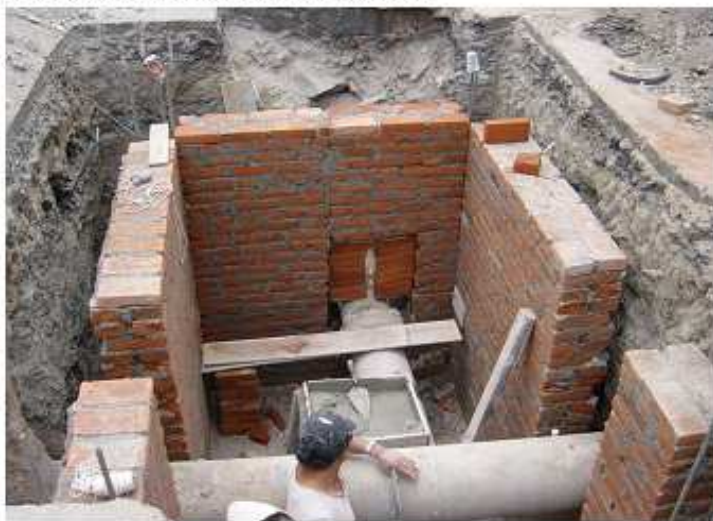
Figura 81.0.- Construcción de muros en caja de operación de estaciones.
