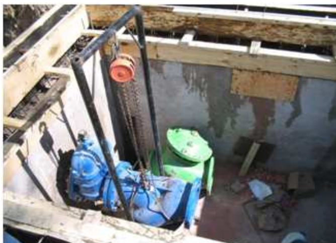
Figura 76.0.- Instalación de componentes de una estación de control de presión.
