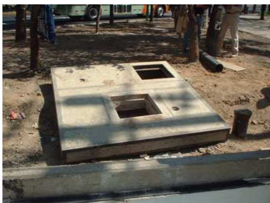
Foto No. 21 Muestra una losa tapa ya colada y lista para instalarse.
