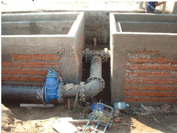
Figura 70.0.- Colocación de fontanería y piezas especiales
