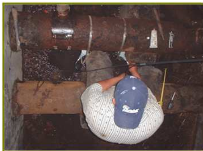
Figura 52.0.- Instalación de Macromedidores.
