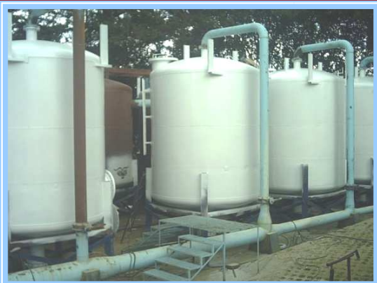
Foto No. 3 Muestra el Mantenimiento preventivo a planta potabilizadora
