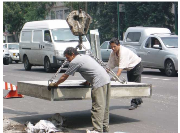
Figura 71.0.- Colocación de tapas de concreto armado
