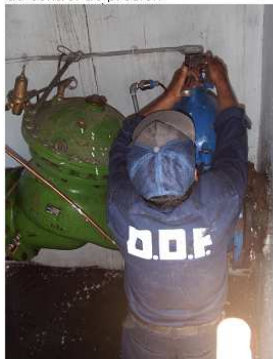
Figura 95.0.- Calibración de válvulas de control de presión
