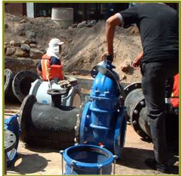
Figura 54.0.- Preparación de una válvula de seccionamiento para su instalación.
