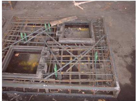
Foto No. 18 Muestra el habilitado del acero de refuerzo, correspondiente a la losa tapa de la caja de medición.
