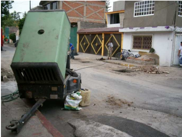
e) Se observa el equipo para realizar reconexiones en tomas domiciliarias.
