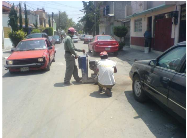
b) Corte con sierra en pavimento de concreto asfáltico.
