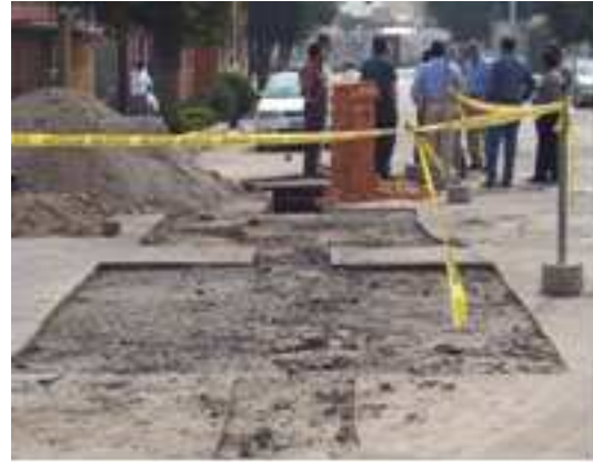
Foto No. 4 Muestra la demolición de la carpeta asfáltica para la construcción de las cajas de medición de gasto y control de presiones.
