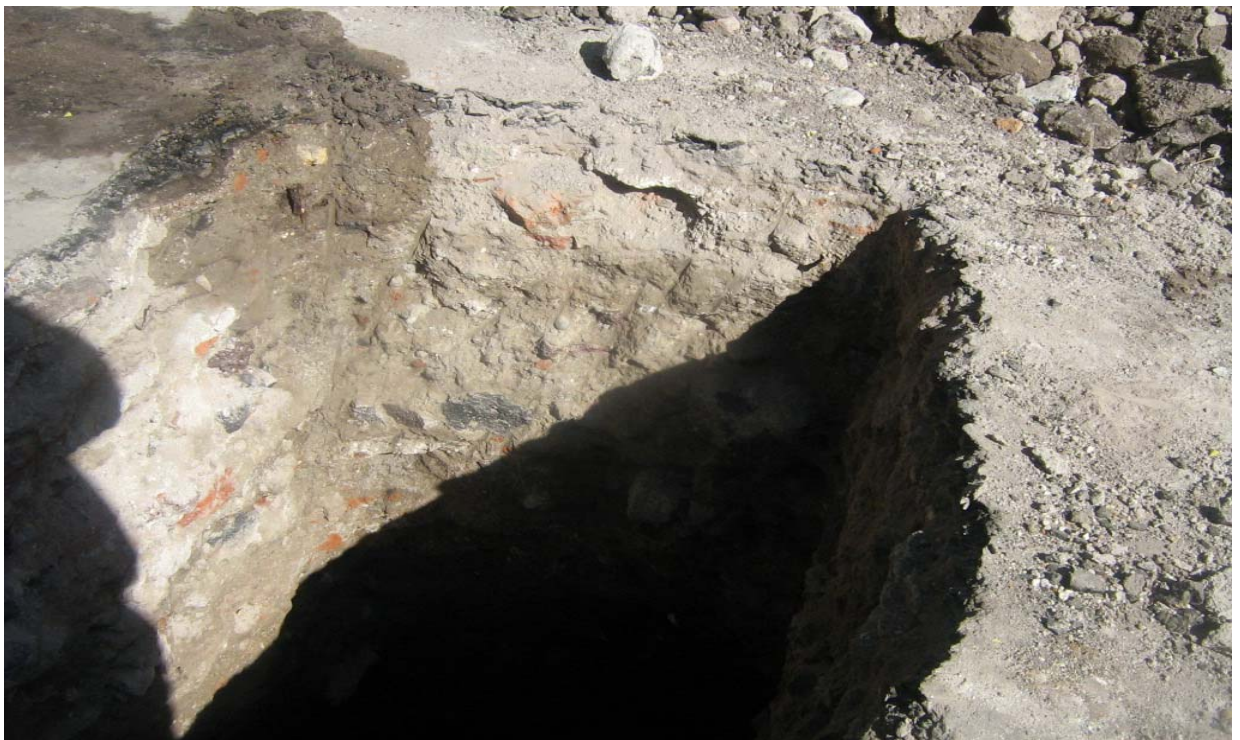
FOTO 18 Materiales presentes en la pared del pozo a cielo abierto 2,
