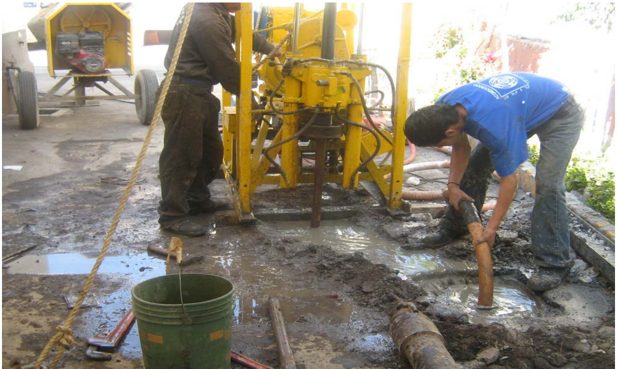
FOTO 9 Personal y equipo durante la perforación del sondeo mixto 1, SM - 1.
