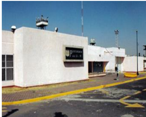
Penitenciaría del DF Arquitectura. Tipo Peine Capacidad. 800 internos. Superficie. 40,000m 2
