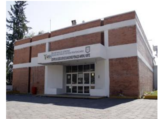
Centro de Ejecución de Sanciones Penales Varonil Norte Superficie. 10,400m 2
