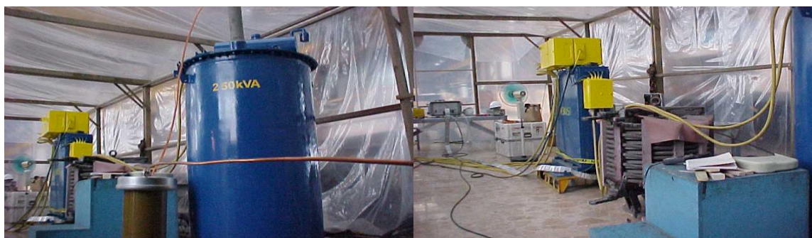
Fig 3..7.-Equipo de prueba para alto al generador recién embobinado.
