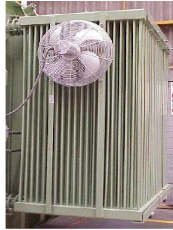
**Fig. 23 Radiador tipo tubular.**
