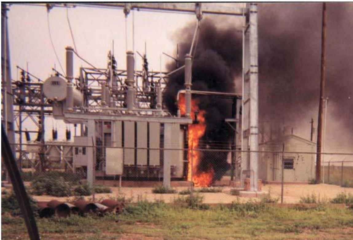
**Fig.71 Explosión del transformador**
