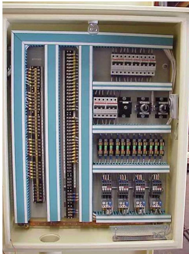
**Fig. 36** Caja de conexiones
