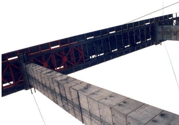
Fotografía II.1.1.- Vista inferior del puente “Barranca Begoña” ubicado en la carretera Morelia – Lázaro Cárdenas, en el estado de Michoacán, base del estudio y donde se puede apreciar la unión pila-superestructura. Fuente: CENAPRED, “Propuesta de investigación: pruebas de laboratorio de pilas rectangulares huecas y macizas ante carga lateral”, Información proporcionada durante la prestación de servicio social por el Dr. Oscar López Bátiz, subdirector de estructuras y geotecnia.
