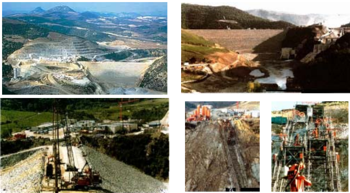
Figura 5.35 Fotografías de la presa Agly (Soletanche Bachy, 1999)
