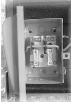
Figura E. Ejemplo de un interruptor donde pueden ir alojados los fusibles tipo cartucho de casquillo.
