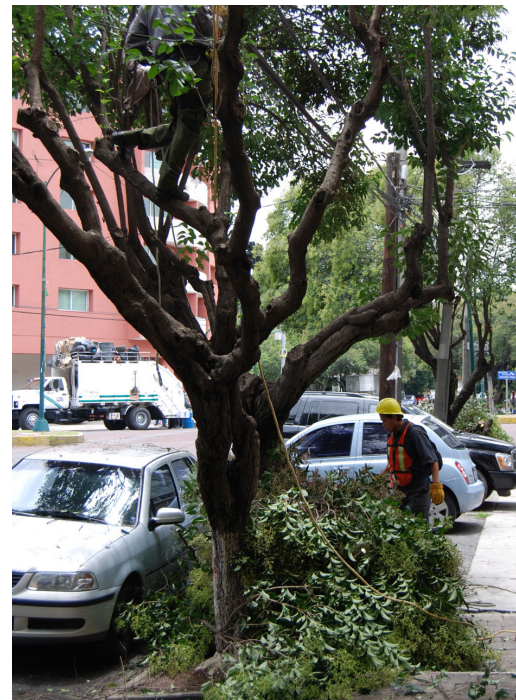
Gráfico No. 49 Podas efectuadas para evitar que las ramas estorben los cables.
