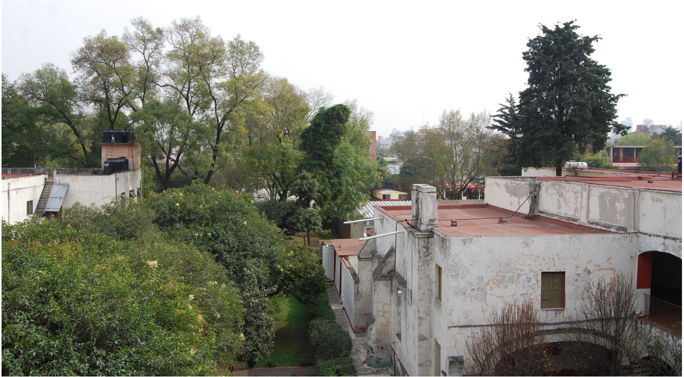
Gráfico 4. Estado actual de la Casa de la Hacienda de San Borja convertida en el Internado No. 1 “Gertrudis Bocanegra de Lazo de la Vega”.
