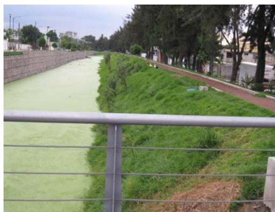
Fotografía 12. Canal Nacional. Vista con el camino perteneciente al lado de Iztapalapa (orientación sur a norte, desde el “puente 7”). Agosto de 2008. Foto:OACG
