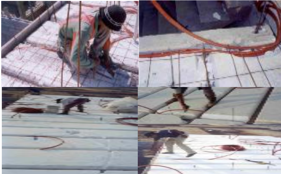
IV.65 Instalaciones eléctricas alojadas en losas aligeradas
