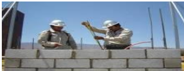
Figura IV.8 Colocación de aceros verticales
