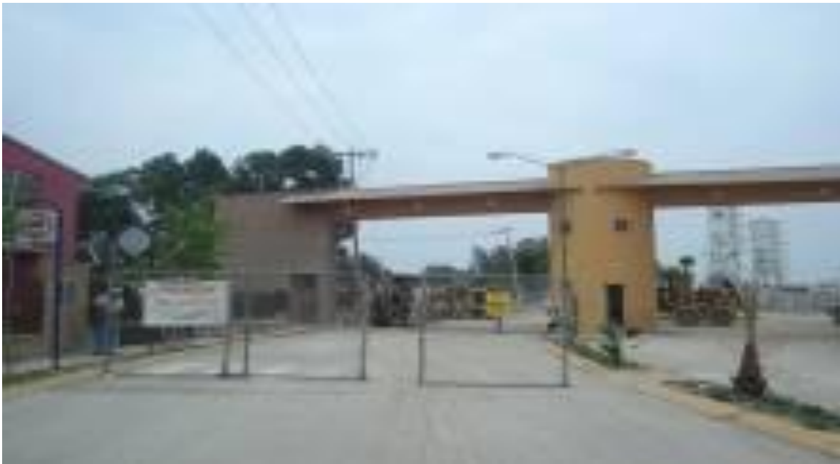
III.2 Imagen de accesos provisionales
