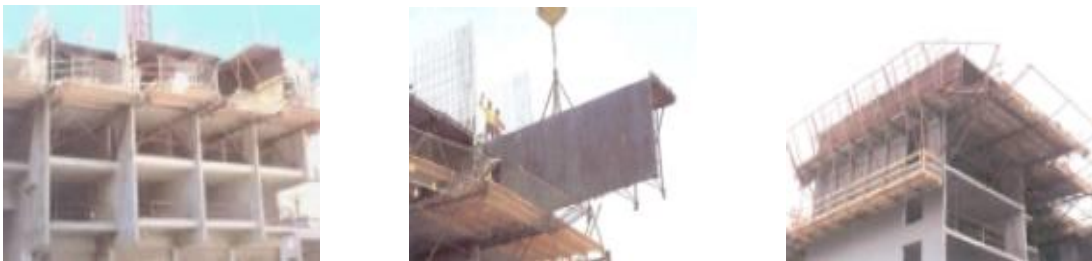
IV.23 Maniobras de Cimbra Túnel
