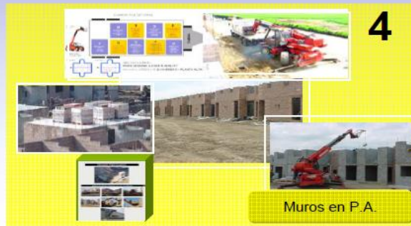
Figura VII.4 Formación de "Kits" en muros y losas de entrepiso
