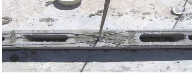
Figura IV.16 Detalle de colocación de ganchos
