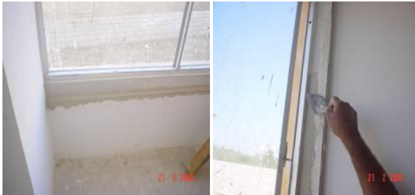
Figura IV.77 Emboquillados en puertas y ventanas
