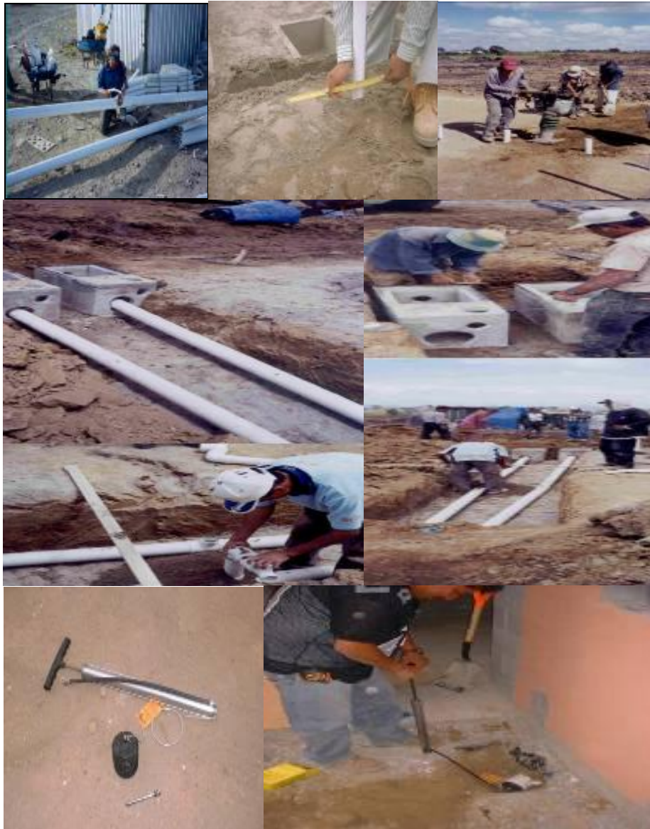
Figura IV.47 Proceso constructivo en la colocación de Instalaciones Sanitarias
