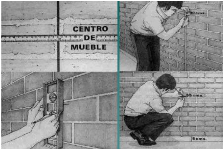
Figura IV.50 Trazo en muebles de baño
