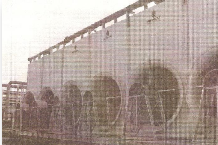
Figura 2.39. Torre evaporativa de tiro inducido.
