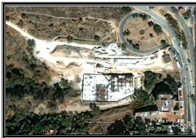
Fotografía 7. Construcción de fraccionamientos
