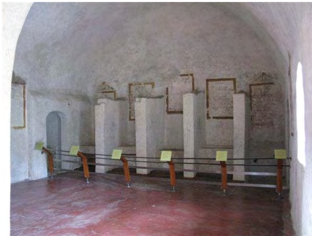
Figura 60. Letrinas y baños localizados sobre la cocina del claustro de Tepoztlán.
