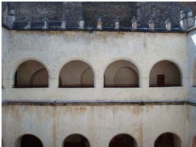
Figura 35. Entre la moldura que divide el claustro bajo del alto, se aprecian dos de las gárgolas que drenaban el agua cuando sólo existía la planta baja.
