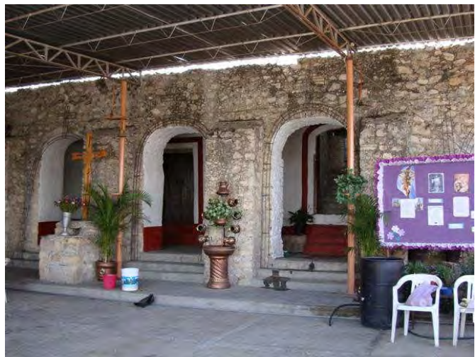
Figura 28. Fachada oriente del corredor del claustro bajo de Anenecuilco, en la que se perciben los delgados contrafuertes sobrepuestos en los pilares.
