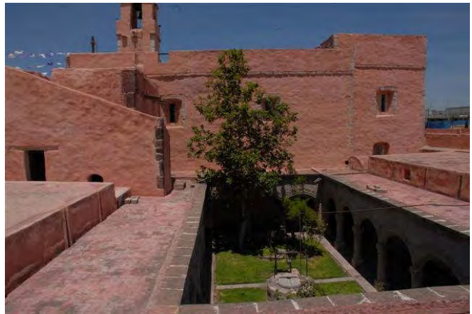
Figura 21. Fachada sur del conjunto religioso de San Francisco Tlahuelilpa.
