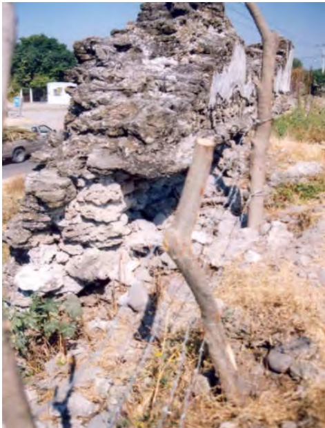
Figura 13. Detalle del desplante del muro atrial del montículo 5 de Olin-tepec.
