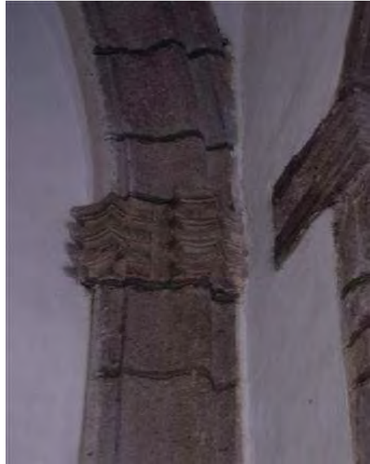
Figura 12. Detalle de la imposta moldurada del muro testero de la capilla abierta de San Miguel Anenecuilco.
