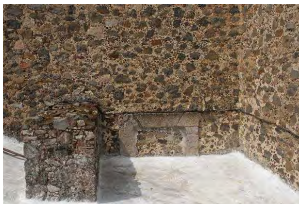
Figura 26. Vano adintelado que se observa por el exterior del muro norte del templo de Tepoztlán, indicio de una techumbre más baja.
