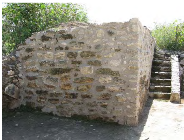
Figura 4. Dependencias localizadas en la plataforma sur del asentamiento de Las Bóvedas.
