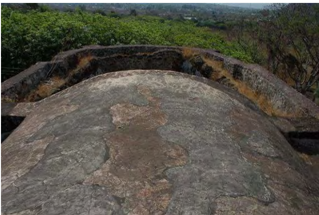
Figura 23. Detalle del ábside semiesférico y de la junta constructiva con la que se adosó el tercer tramo del templo de la Asunción Ahuatlán.
