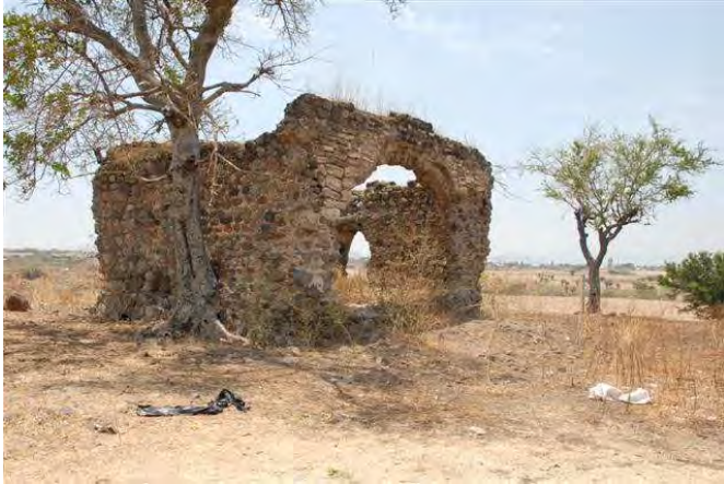
Figura 25. De planta cuadrada, la capilla abierta de Calalpan, consta de un arco de medio punto.
