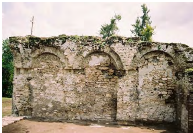
Figura 34. Arcos formeros del muro norte del templo de Olin-tepec.
