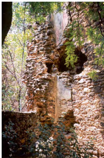
Figura 10. Huella del mechinal en el muro norte del templo de Teopanco que evidencia la existencia de una tarima para el coro.
