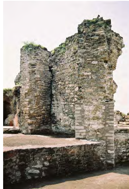
Figura 36. Contrafuertes del lado norte del templo de Olin-tepec.
