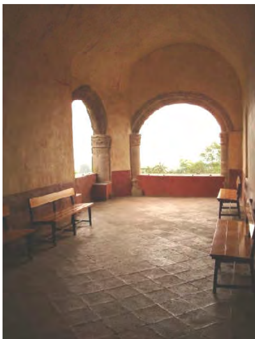
Figura 69. Espacio hoy denominado como "mirador".
