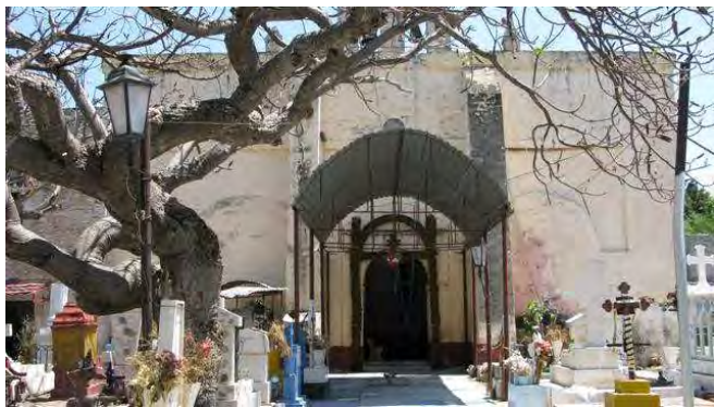
Figura 8. Templo de San Miguel Anenecuilco. El vano central marca el tramo de la capilla abierta.
