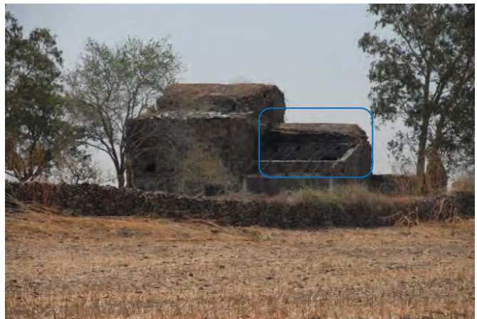
Figura 26. La visita agustina de Mixtlalcingo muestra tres cuerpos de fábrica. El que se aprecia a la derecha, cuya bóveda es más baja, pertenece al cuerpo de la capilla del altar mayor.
