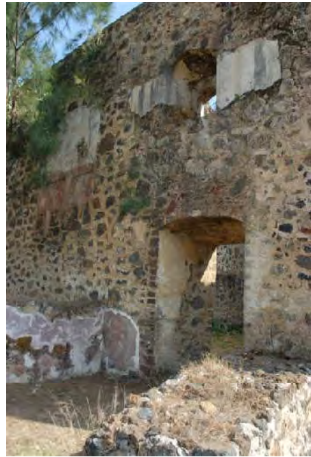
Figura 32. Restos de aplanados blanco y rojo del paramento norte del presbiterio del templo, los que indican la posible existencia de un claustro alto en Ahuatlán.
