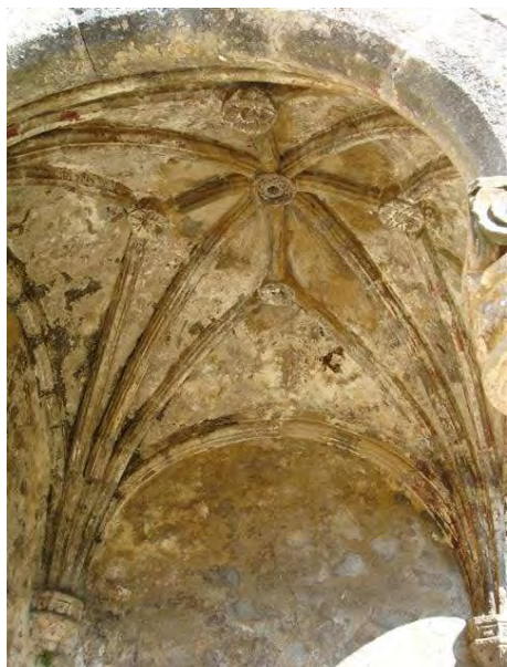
Figura 17. Bóveda nervada de la segunda capilla posa de Tepoztlán.
