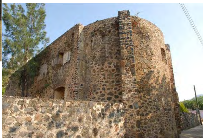
Figura 25. Contrafuertes adosados al muro testero del presbiterio del templo de Ahuatlán.
