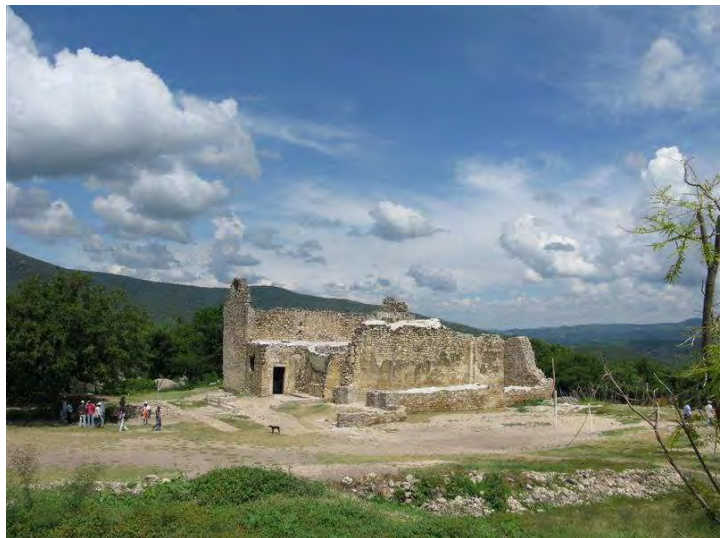
Figura 13. Panorámica de norte a sur que muestra los vestigios del conjunto religioso de las Bóvedas, Tlaquiltlenango, Morelos.
