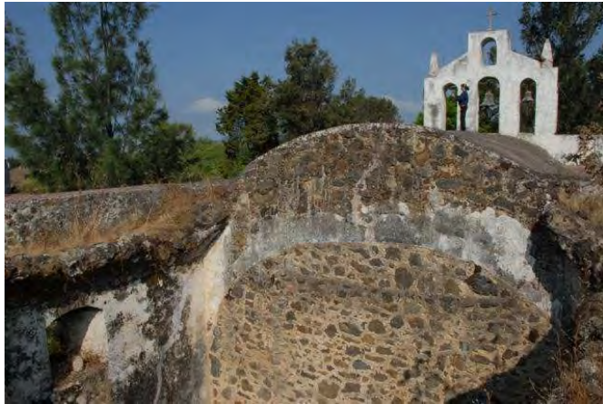
Figura 27. Vista hacia el poniente en la que se observa la huella de la altura y del espesor que guardaba la bóveda del presbiterio del templo de Ahuatlán.
