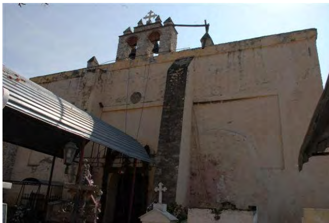
Figura 21. En la fachada principal del templo de San Miguel Anenecuilco se aprecia cómo los tres vanos de medio punto están situados a más baja altura y enmarcados por un alfiz.
