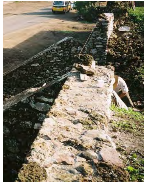
Figura 14. Restauración del muro atrial del montículo 5 de Olin-tepec.
