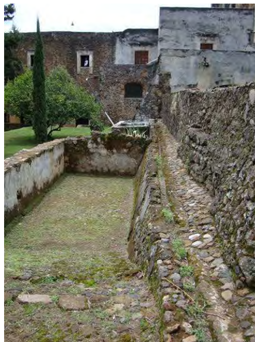
Figura 4. Canal que pasa por detrás de la primera capilla posa, por el que se introducía el agua al convento.
