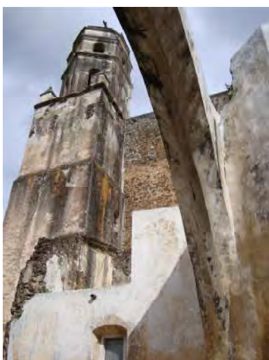
Figura 29. Detalle que muestra como la torre sur del templo de la Natividad se aoya en lo que fue el coro de la capilla abierta de Tepoztlán.
