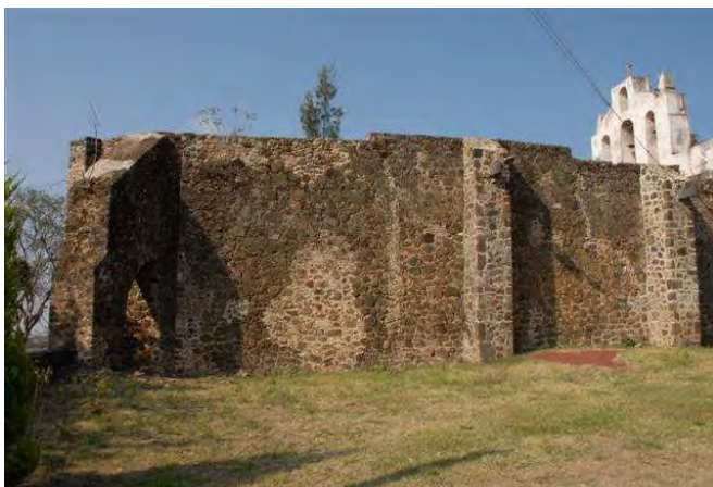
Figura 24. Arbotante y contrafuertes del lado norte del templo de Ahuatlán.
