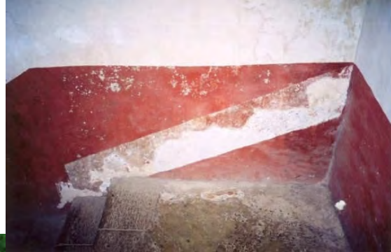
Figura 49. Huellas que indican la existencia de una primera escalera de ascenso al claustro alto del convento de Tepoztlán.
