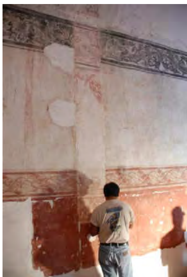
Figura 42. Una de las huellas de los muros transversales que dividieron la sala de profundis durante la construcción del claustro alto.
