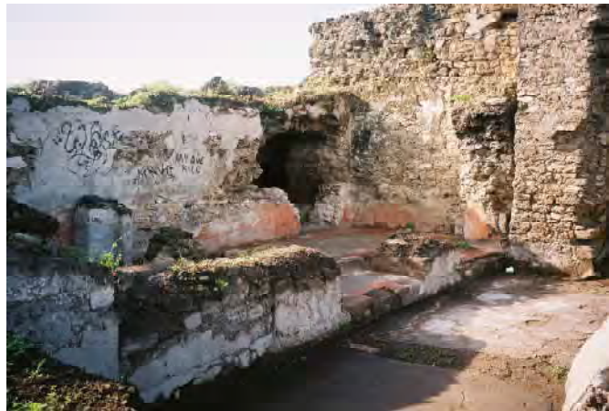
Figura 7. Fachada poniente de los restos del palacio prehispánico de Olin-tepec.
