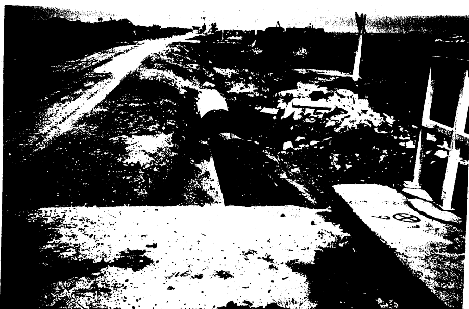
Obras de Asenta- miento del Lago Churubusco: Al fondo, un pozo somero; y en primer plano, un collector de aguas
