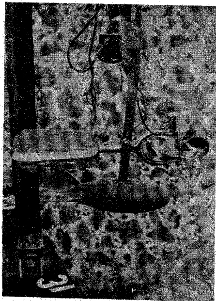
17. Estación hidrométrica Potrerito. Molinete con el que se realiza el aforo de la corriente Barranca del Monte.
