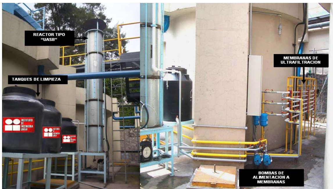
Figura 4.3 Arreglo general del sistema UASB- membranas (Cid, 2007)
