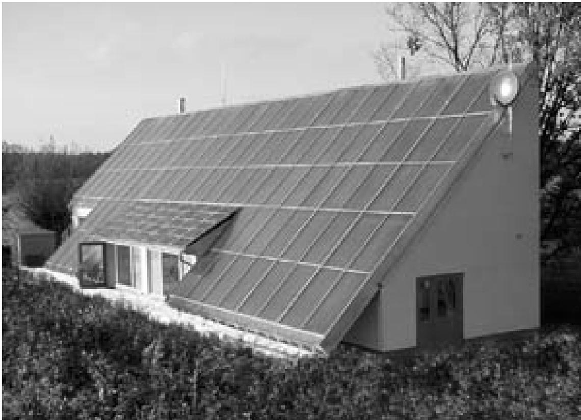
*Figura 3.4 Colectores Solares.*
