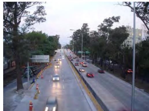
20. En esta imagen se aprecia al fondo el nuevo "puente de Xoco", el paso elevado de automóviles que da continuidad a Río Churubusco. Los automóviles toman la primacía en el diseño de la ciudad.
