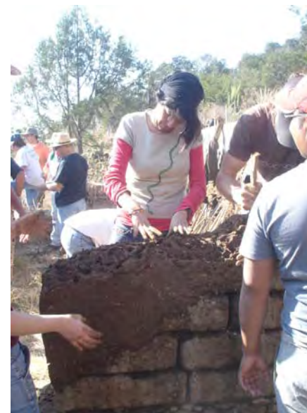
103. Imagen que muestra el proceso participativo en la construcción de los sistemas de tierra cruda
