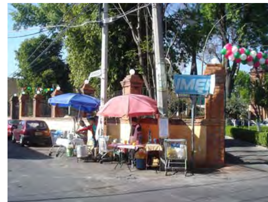
35. Vista de la barda que rodea el atrio de la iglesia. Calles Real de Mayorazgo y San Felipe
