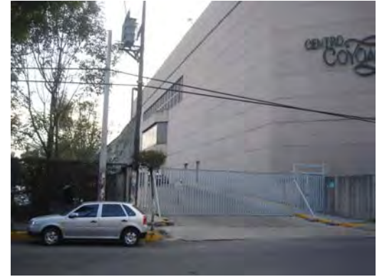
87. Centro Coyoacán, en su fachada hacia la calle Real de Mayorazgo
