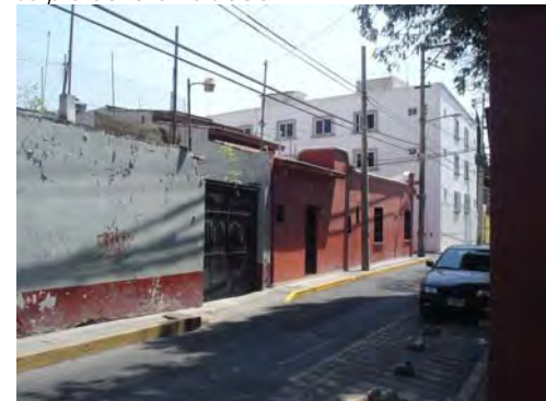
72. Calle Puente de Xoco. Se observa en esta fachada restos de la tipología de pueblo: el rodapié rojo en la barda, la comunicación de las construcciones con la calle, la altura uniforme que es interrumpida por el edificio de departamentos que se ve al fondo, tanto por la altura como por la ausencia de ventanas al nivel de la calle. Las banquetas son muy estrechas y la vegetación en la vía pública, nula
