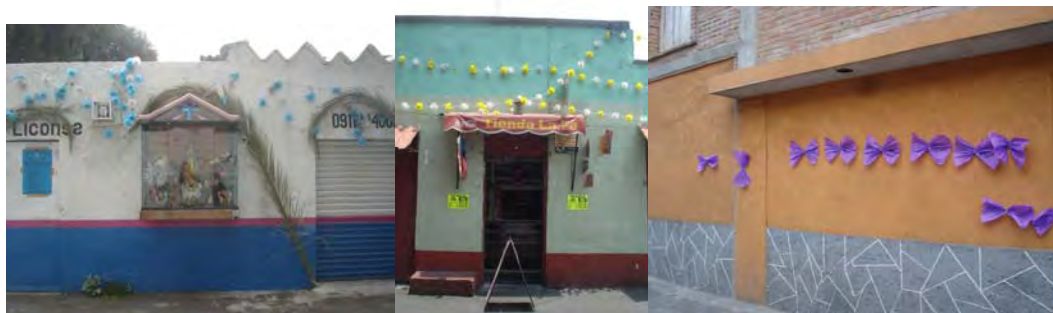
37. Se observan las huellas de las fiestas en las fachadas, en el corazón del pueblo de Xoco. Nótese la ausencia de banquetas y las escala del entorno
