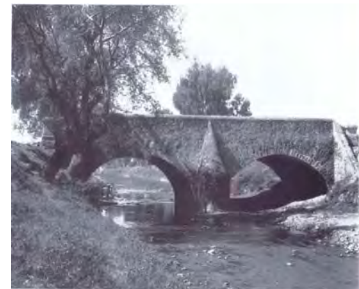
19. Puente de Xoco.
