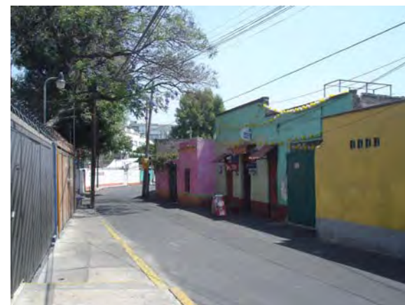
39. Calle San Felipe: lotes unifamiliares provenientes de la traza original. La escala es digna de recatarse, así como el diálogo con la calle: ventanas y puertas en franca comunicación con el espacio público, en contraste con la acera de enfrente que se cierra por completo a la vía pública
