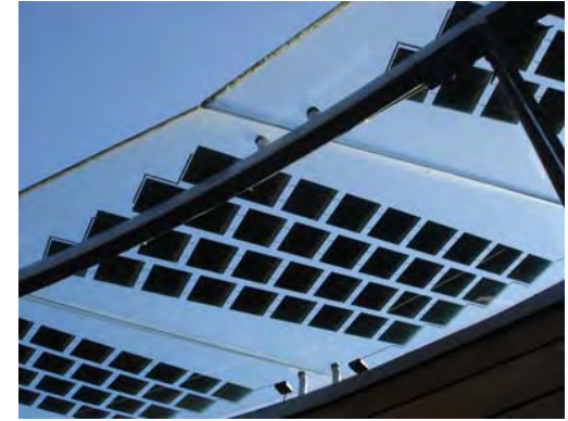
100. Celdas solares propuesta para la estructura del mercado: permiten el paso de la luz, y captan energía solar
