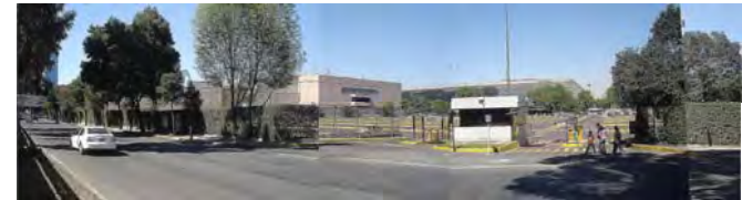
94 Vista del estacionamiento Bancomer desde el arroyo lateral de la avenida río Churubusco
