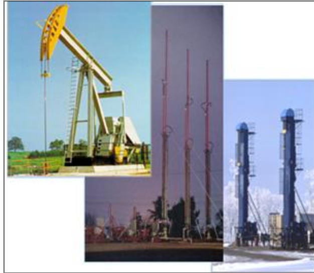
Figura 1.19. Distintas unidades de bombeo mecánico
