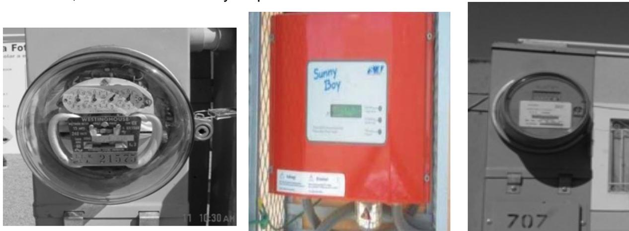
Figura 29 Inversor y equipo de medición digital con medidor analógico.
