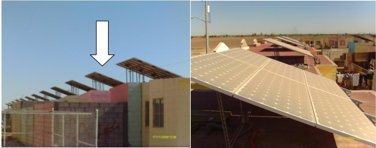
Figura 28 Paneles solares sobre viviendas en Valle de las Misiones.
