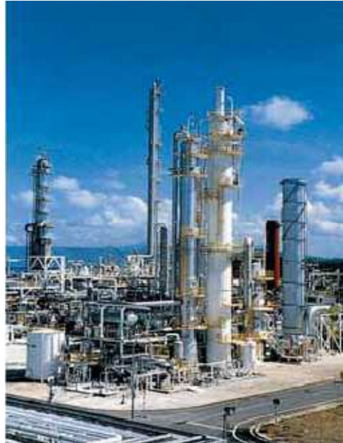
Figura 10. Planta en Malasia con captación posterior a la combustión [IPCC, 2005]
