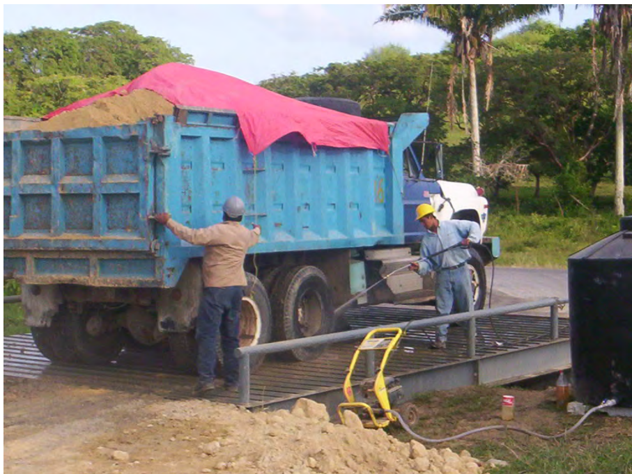
Figura 2.3. Camiones transportando material térreo cubiertos con lonas para evitar la dispersión de polvo.
