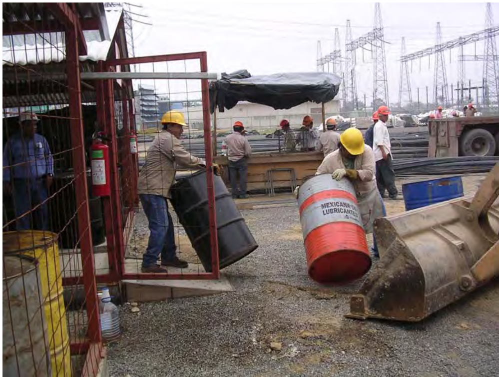
Figura 2.6. Retiro de residuos peligrosos del sitio del proyecto
