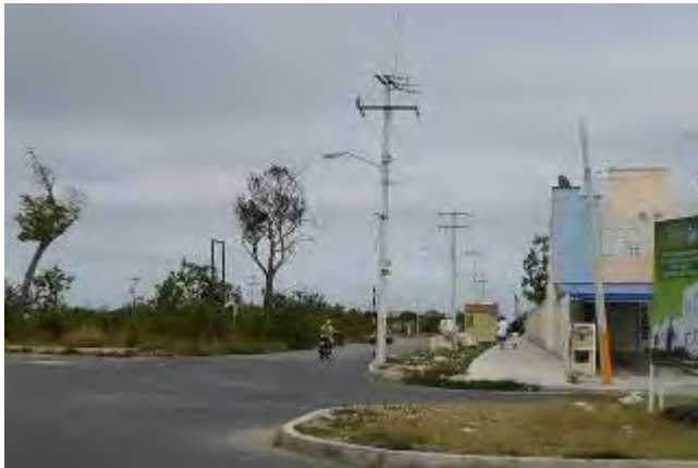
AV LAS TORRES ESQUINA CON CALLE SIN NOMBRE
