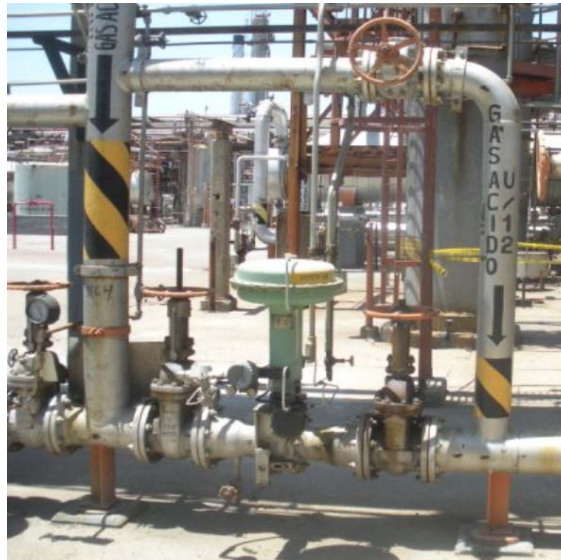
Figura 50. Fotografía del control de presión torre 11C3 Tren Poniente en la Planta U11
