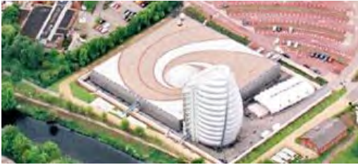
Vista aérea del conjunto
