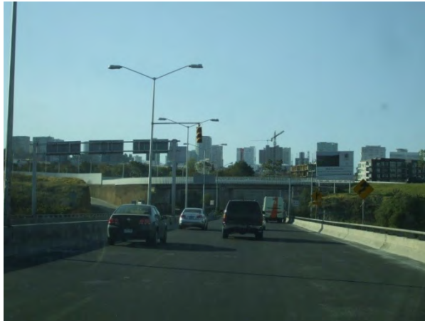
Figura 7 Acceso a Santa Fe desde Av. de los Poetas.
