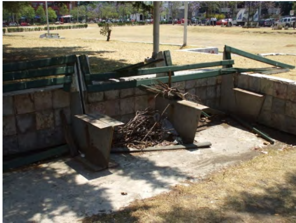
Figura 2 Banca destrozada en parque Centro de Ciudad.
