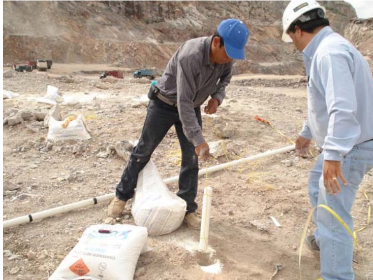
Figura 22. Colocación del cebo en el barreno
