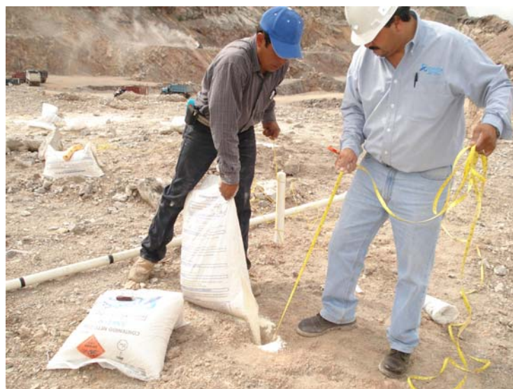
Figura 23. Cargado del barreno con agente explosivo ANFO
