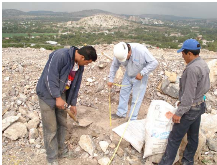
Figura 21. Nivelación de barrenos con cinta graduada
