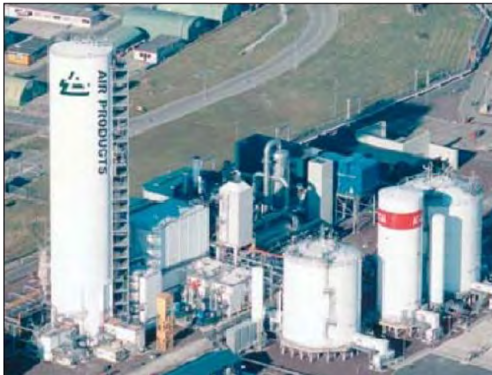
Figura 4.5b Planta de oxígeno de 3000 t/d. (IPCC SRCCS, 2005)
