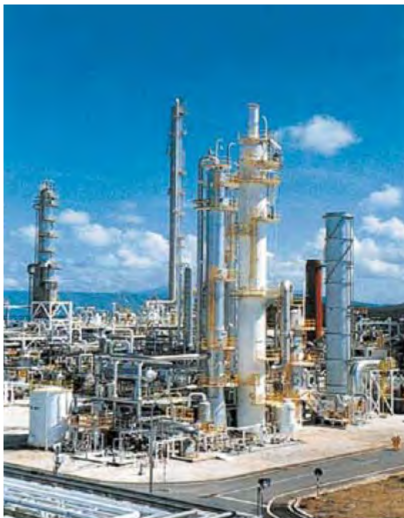
Figura 3.3 Central de captura de 200 tCO 2 /d en Malasia usando un proceso de disolventes químicos. (IPCC SRCCS, 2005)
