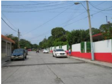
Las calles no tienen drenaje
