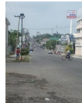
Calles en mal estado Facilidad de inundación
