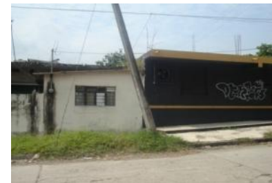
Graffiti y casas en mal estado
