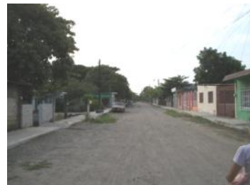
Avenidas de terracería
