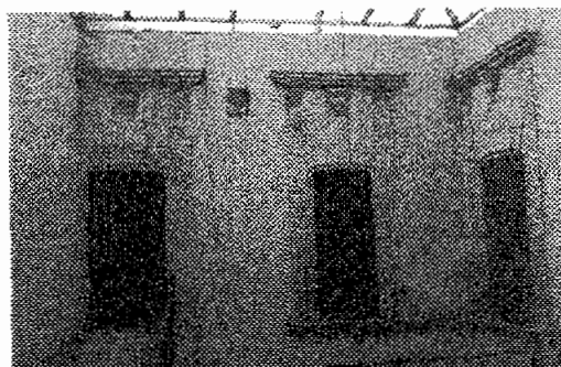
14. Vista poniente, planta noble y pasillo - Piso sin acabado
