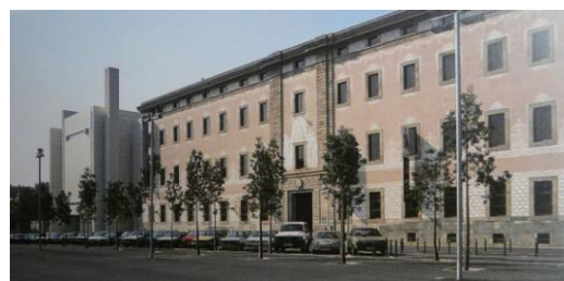
Restauración de la casa de Caritat que forma parte del conjunto.
