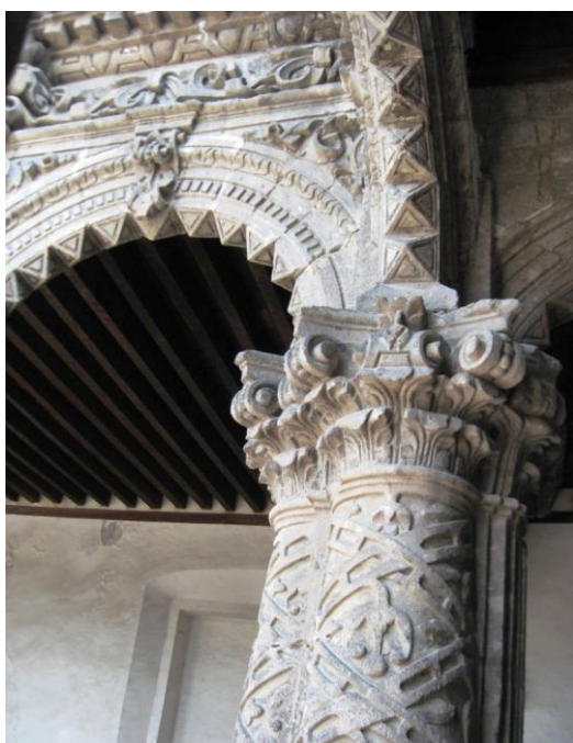
Vista de una columna de la Planta Alta.
