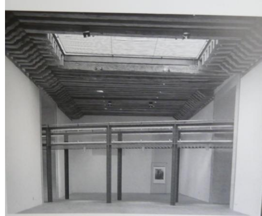
Imagen interior del puente diagonal.
