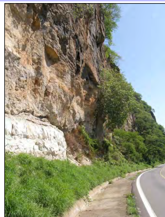
VEÁSE EL CONTACTO MUY CLARO ENTRE LA TOBAS BLANDAS QUE SUBYACE A LA UNIDAD DE DACITAS QUE PRESENTAN UN FRACTURAMIENTO CASI VERTICAL
