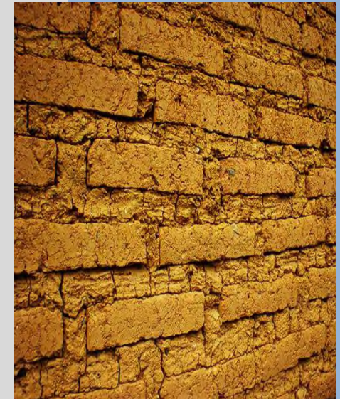
Imagen: muro de adobe
