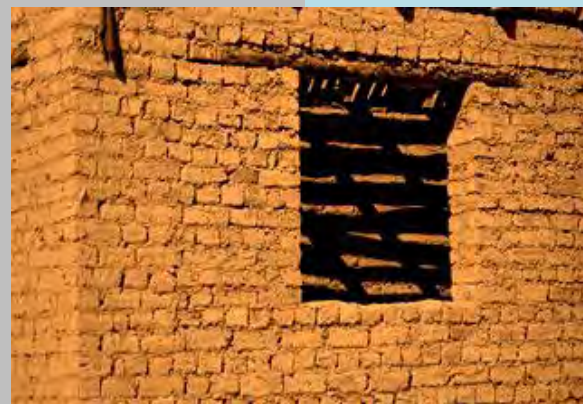
Construcción con bloques adobe.
