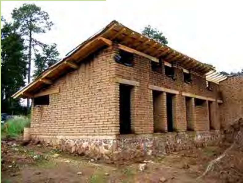
Construcción de adobe con cubierta de carrizo. Oaxaca. México.
