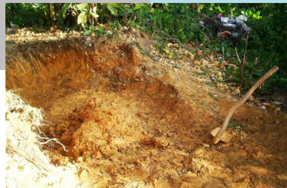
Proceso de extracción de tierra para la elaboración del adobe. San Isidro la Reforma. SSG
