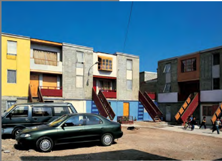
Santiago de Chile; proyecto de viviendas de bajo costo. Realizado con el método de soportes por estudiantes de la universidad católica de Santiago de Chile en conjunto con la empresa COPEC y el Arq. Alejandro Aravena.
