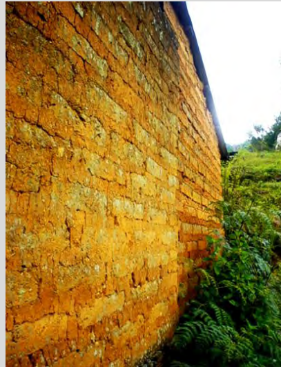
Imagen: 4. Muro-adobe. Se muestran dos diferentes muros de adobe de distintas viviendas, el de la izquierda con mayor desgaste que el de la derecha.
